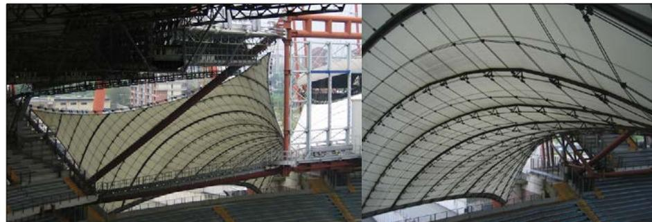
Figura 1.37 Stadio delle Alpi, Torino, particolare della parte in con struttura a membrana e dettaglio; foto Studio Ossola
