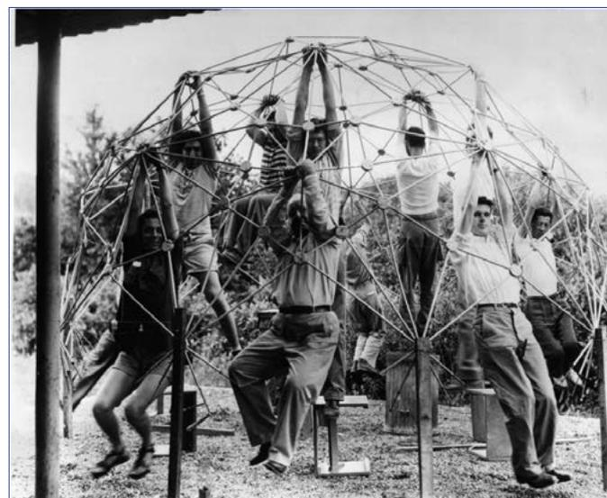
Figura 3.12 Fuller con il gruppo del workshop testa la resistenza della cupola
