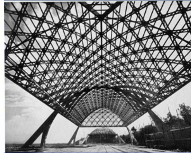
Figura 2.12: Una delle Aviorimesse di pier Luigi Nervi realizzata tra 1935-1942
