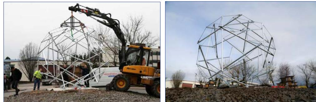
Figura 1.41 e 1.42: Tensegrity Sphäre, fase di costruzione e sfera tensegrale finita, da Markus Heinsdorff
