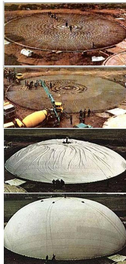
Figura 4.18: Fasi della costruzione di un edificio con il metodo Bini
