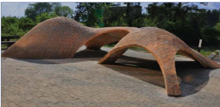
Figura 2.11 Struttura a guscio realizzata con la tecnica della volta catalana.
