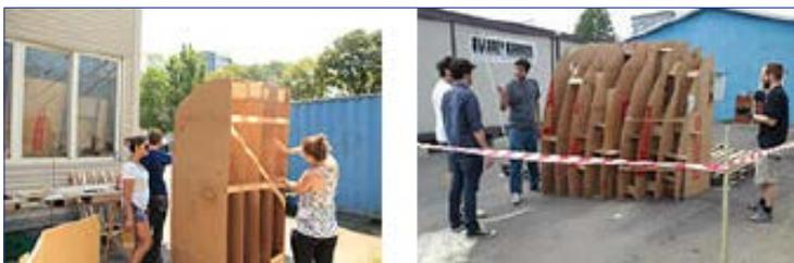
Figura 6.10: Assemblaggio centine. Foto M. R.
