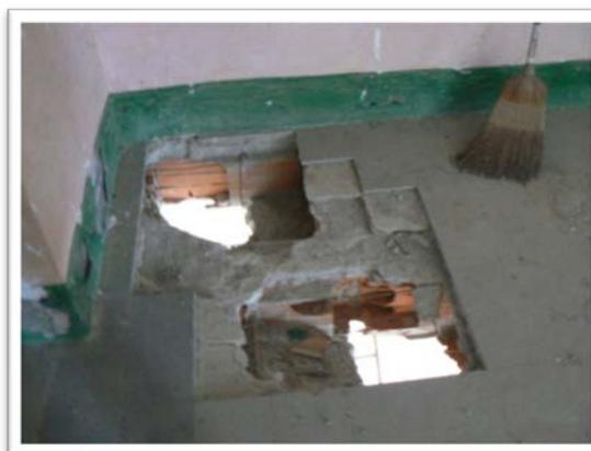
*Figura 10 e 11 - Punti di presa 9 e 10: infiltrazioni, distacco di intonaco e indagini distruttive*
