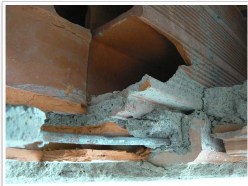
*Figura 47 - Particolare del piede dei travetti prefabbricati con vista di parte dell'armatura degli stessi*
