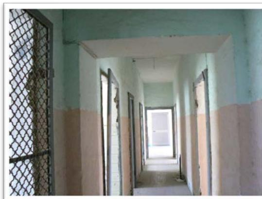
*Figura 8 e 9 - Punti di presa 7 e 8: arredi accatastati e infissi deteriorati*
