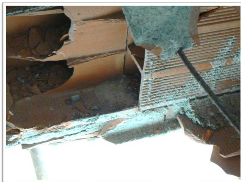
*Figura 48 e 49 - Particolare del piede dei travetti prefabbricati*
