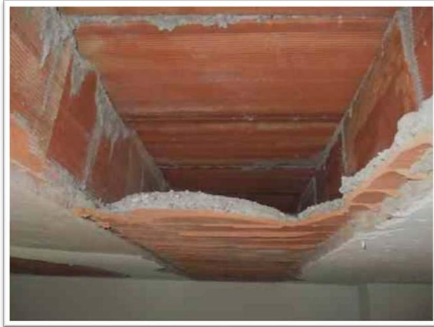
*Figura 46 - Vista dello scatolare formato dalle due tavelle e dai travetti prefabbricati*
