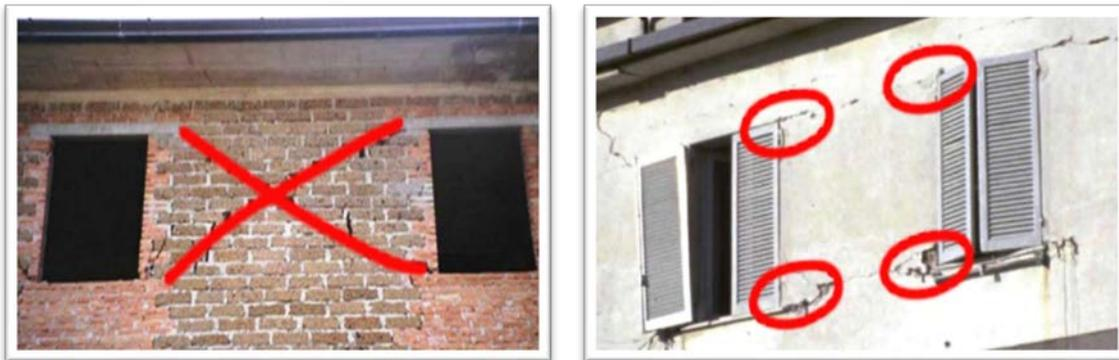
Figura 63 e 64 - Meccanismi di rottura per taglio e presso flessione
