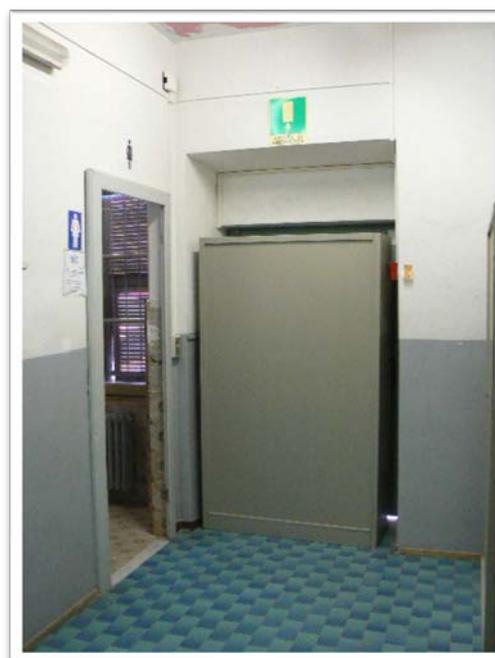
*Figura 6 e 7 - Punti di presa 5 e 6: cartongesso antisfondellamento e uscita di sicurezza bloccata*
