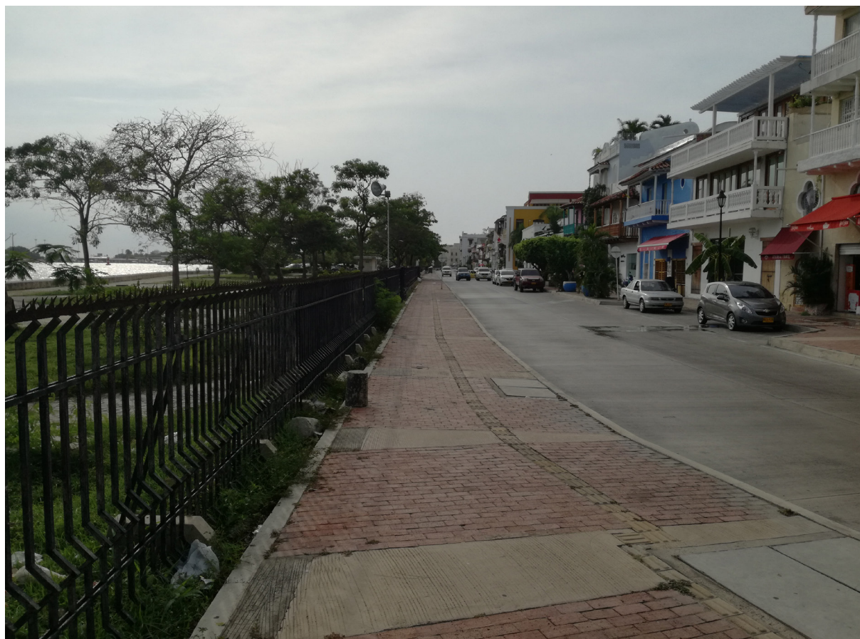
Fig.117: Presenza di barriera di separazione che delimita la zona privata da quella pubblica.
