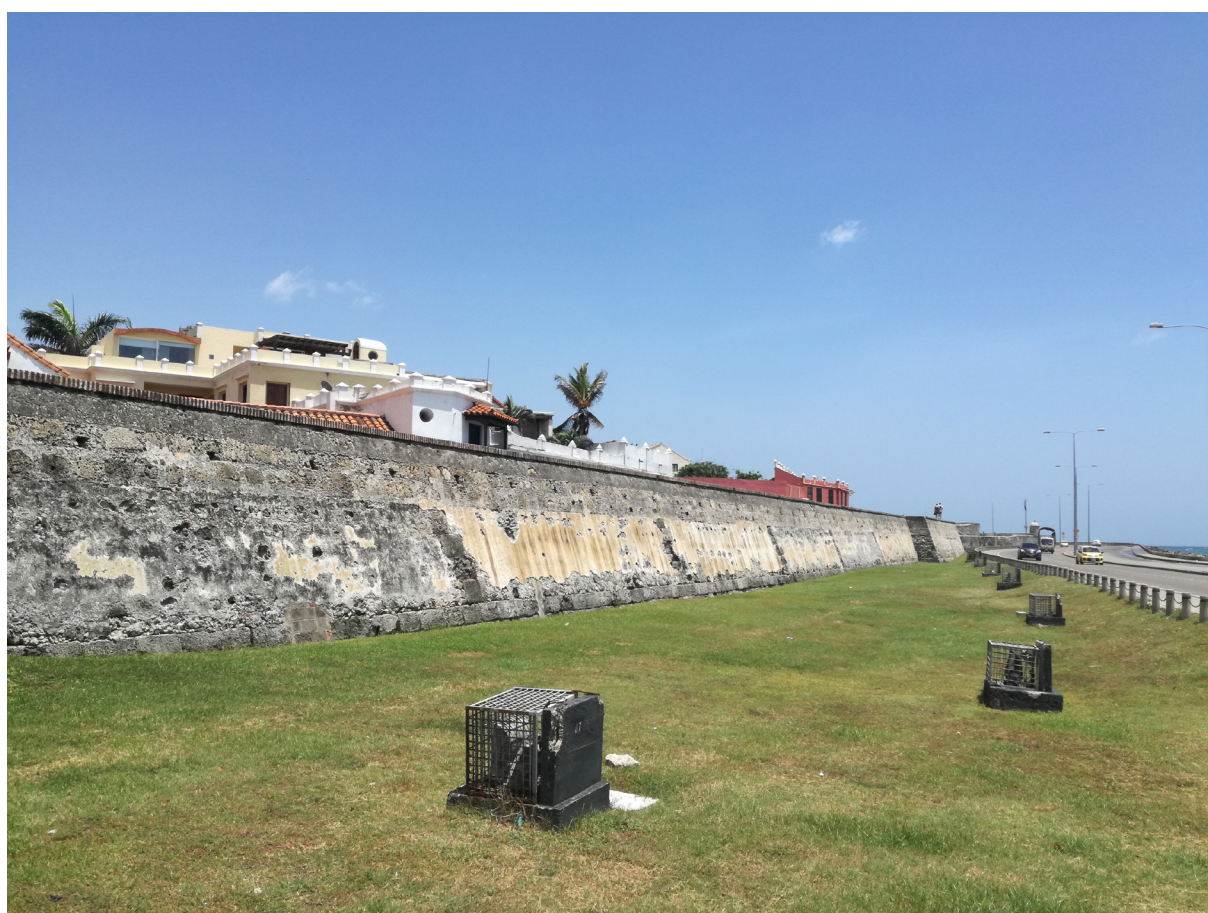
Fig. 16: Vista esterna delle mura da Avenida Santander.
