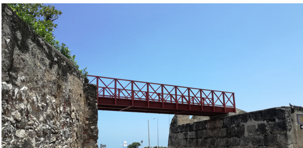
Fig. 109: Passerella che collega il baluarte de San Francisco Javier con il baluarte de Santiago Apostol.
