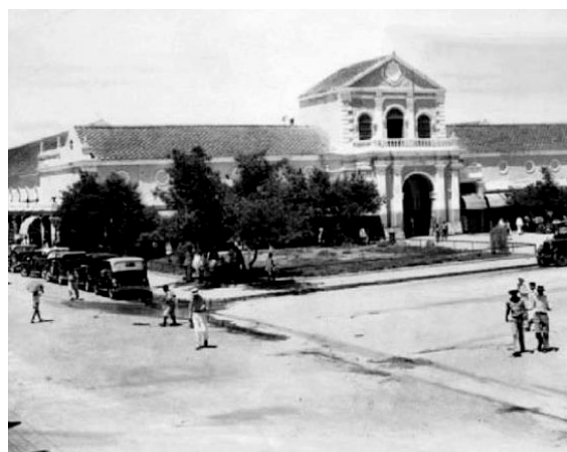
Fig. 68: Facciata del Mercado Público di Getsemani. Fonte: http://tres.memoriasdelalibertad.org
