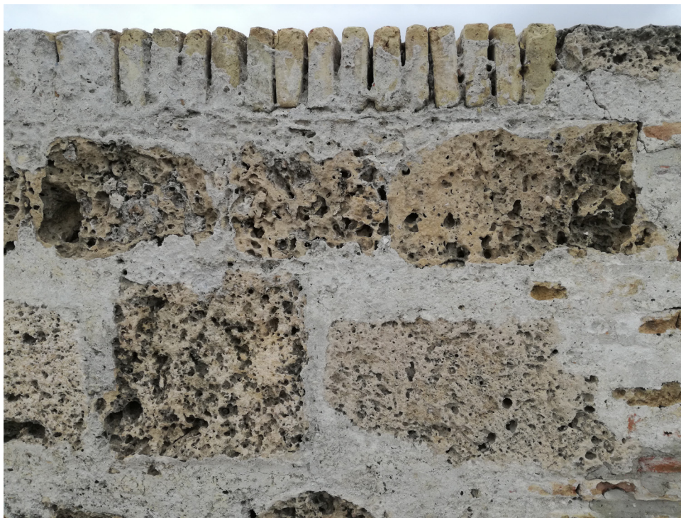
Fig. 85: Alveolizzazione del materiale lapideo del baluarte. Processo dovuto dall'azione di aria e acqua costanti.
