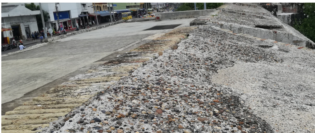
Fig. 100-101: In queste foto si possono osservare tutti i materiali che compongono le mura: pietra, mattone e argamasa .
