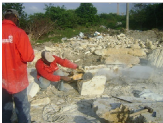
Fig. 106: Lavorazione del nuovo blocco di pietra. Fonte: Informe técnico, reconstrucción de la garita y consolidación de la cortina exterior del baluarte de San Miguel de Chambacú , Sociedad de Mejoras públicas.
