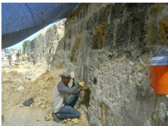
Fig. 105: Eliminazione del blocco di pietra in cattive condizioni. Fonte: Informe técnico, reconstrucción de la garita y consolidación de la cortina exterior del baluarte de San Miguel de Chambacú , Sociedad de Mejoras públicas.
