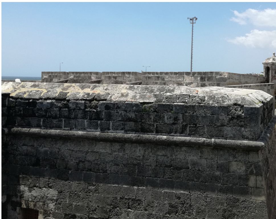
Fig. 103: Baluarte de Santa Catalina. Si può osservare come nelle fortificazioni del Centro e di San Diego i bastioni e le cortine murarie siano costruiti mediante l'applicazione di blocchi di pietra regolari.
