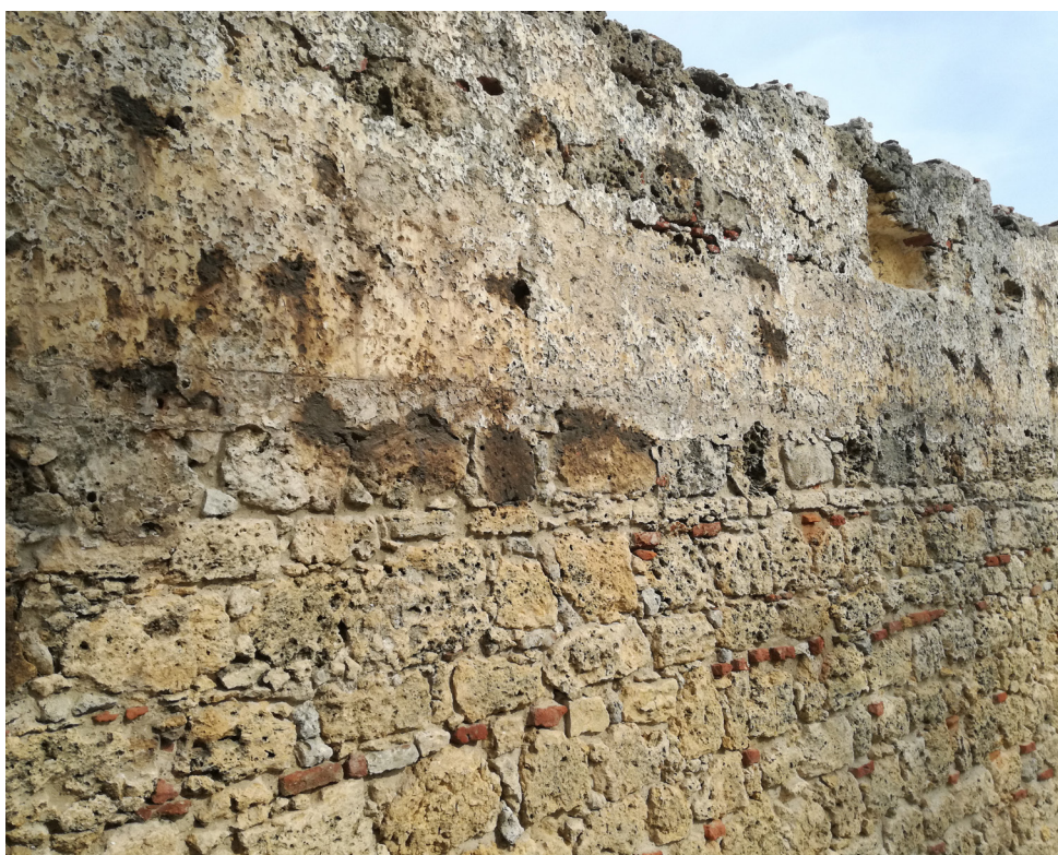
Fig. 104: Cortina muraria che collega il baluarte de San José con El Reducto. Si può notare la muratura mista con la presenza di blocchi non regolari.
