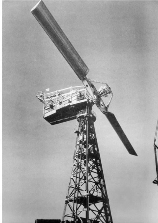
**Figura 1.7 - Turbina Smith-Putnam, Vermont, USA (diametro del rotore 53,3 m, potenza nominale 1,25 MW), 1941. Fonte: [17]**
