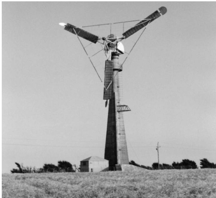
**Figura 1.5 - Turbina Gedser, Danimarca (diametro del rotore 24 m, potenza nominale 200 kW), 1957. Fonte: [17]**
