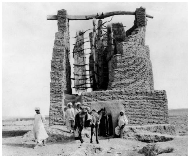
Figura 1.1 - Mulino a vento ad asse verticale. Regione del Seistan, Afghanistan. Fonte: [17]
