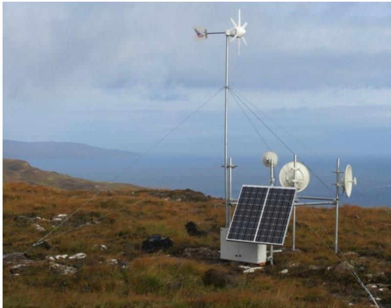
Figura 1.19 - Impianto ibrido eolico fotovoltaico per alimentare un sistema radio. Fonte:[22]
