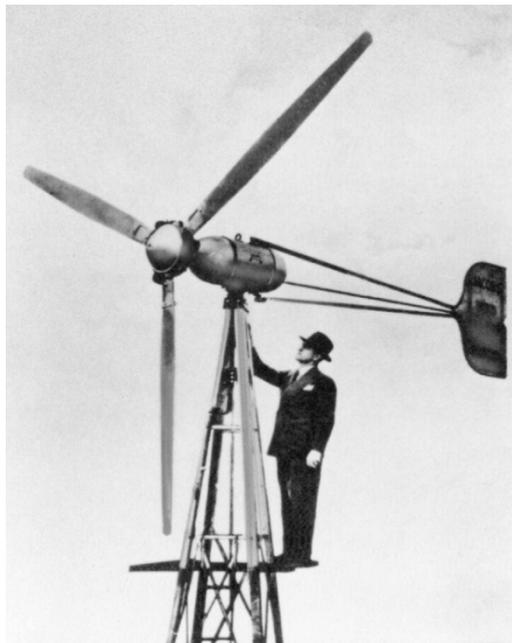
**Figura 1.4 - Jacobs "wind charger" (diametro del rotore  $\cong$  4 m, potenza nominale da 1,8 a 3 kW), 1932. Fonte: [17]**
