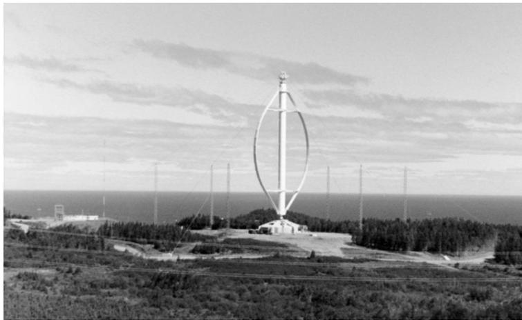
**Figura 1.11 - Turbina Darrieus di tipo  $\Phi$ , potenza nominale 4MW, Canada 1987. Fonte: [17]**
