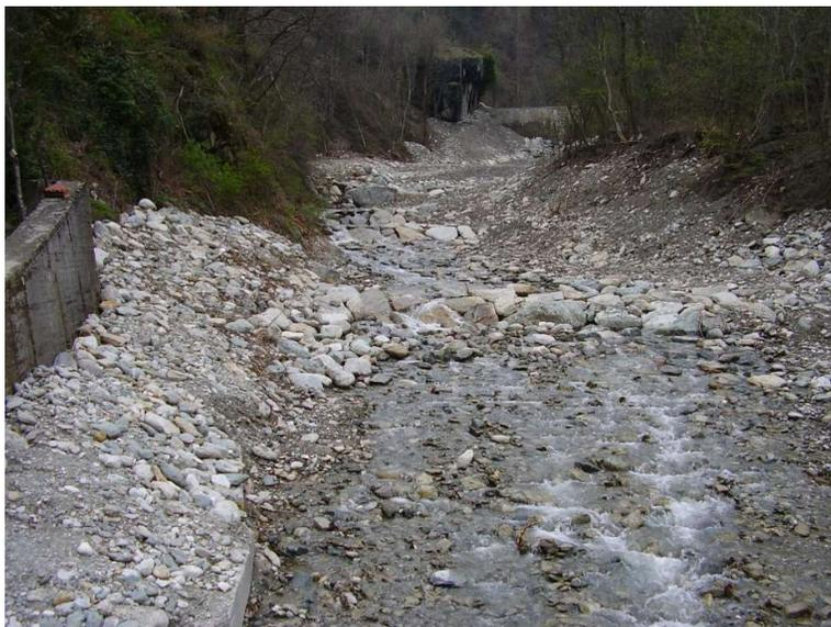
**Figura 30: Sistemazione dell'alveo tipo steep-pool a valle della briglia.**
