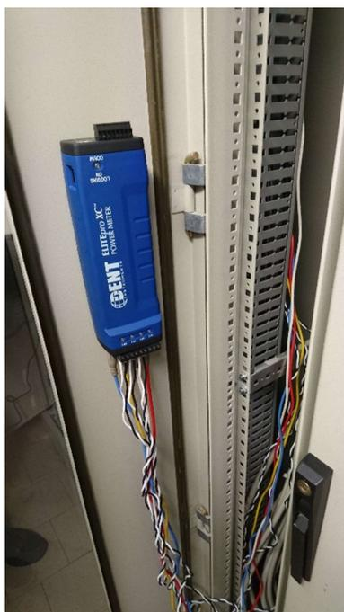
Figura 3.4.14 - ELITEpro XC Recording Power Meter su Quadro 0B
