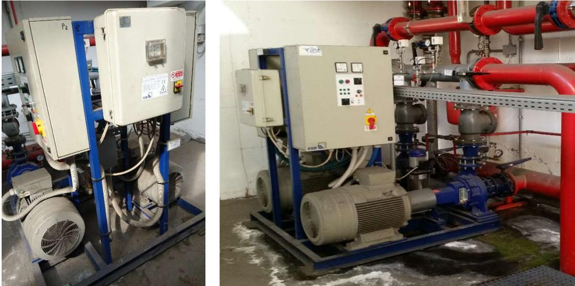
Figura 2.2.8 - Pompe sistema idranti (sinistra), Pompe sistema sprinkler (destra)
