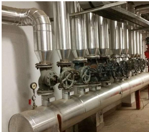
*Figura 2.2.3 - Collettore circuito primario*
