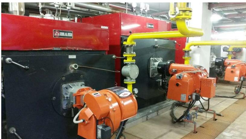
Figura 2.2.1 - Particolare generatori di Vapore
