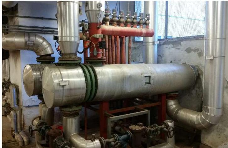
*Figura 2.2.2 - Scambiatori di calore a fascio tubiero vapore/acqua*
