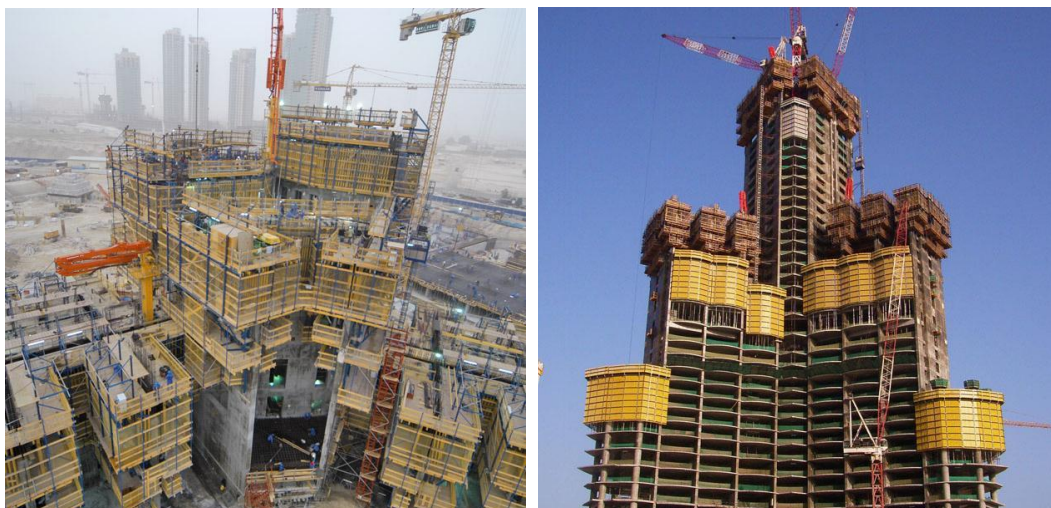
Figure 3.12 e 3.13: Scatti fotografici del cantiere del grattacielo Burj Khalifa di Dubai
