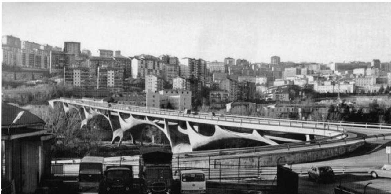
Figura 3.19: Ponte sul Basento (1976)
