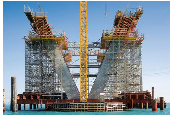
Figure 3.28 e 3.29: Cantiere Stazione Metro, Algeria, Cantiere Sheikh Khalifa Bridge, particolare della costruzione dei piloni a "v"
