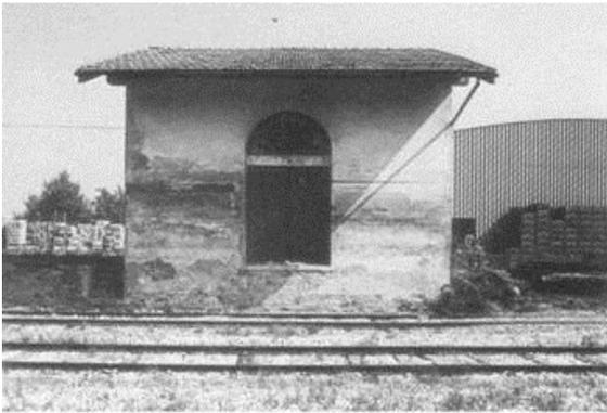
Figura \_37\_ Magazzino merci e piano caricatore di tipo semplice.
