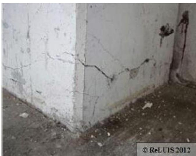
*Figura 26 - Fessurazione alla base del pilastro*
