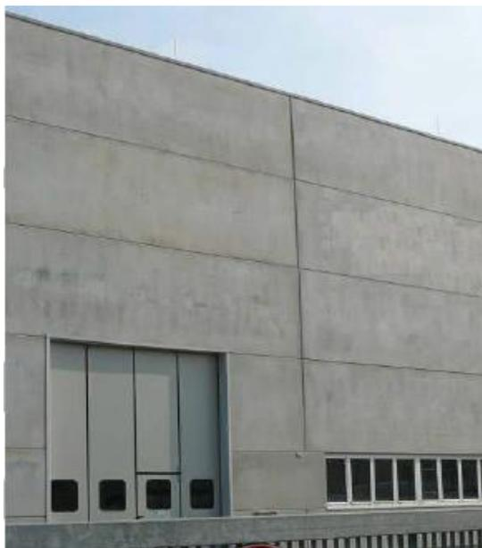
*Figura 12 Esempio di tamponamento con pannelli orizzontali*
