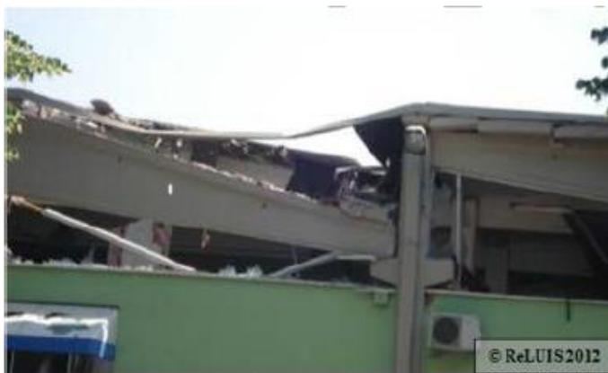
*Figura 13 - Perdita di appoggio della trave principale*
