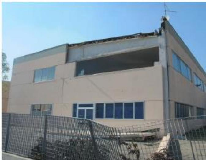
*Figura 19 - Crollo di pannelli orizzontali di tamponamento*
