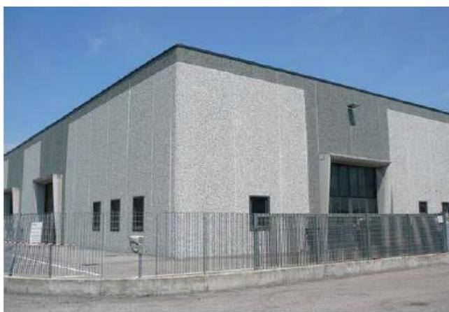
*Figura 11 - Esempio di tamponamento con pannelli verticali*
