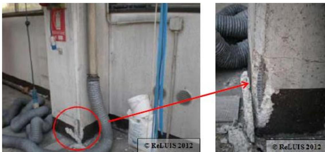
*Figura 27 - Formazione cerniera plastica alla base di un pilastro con instabilizzazione delle barre*
