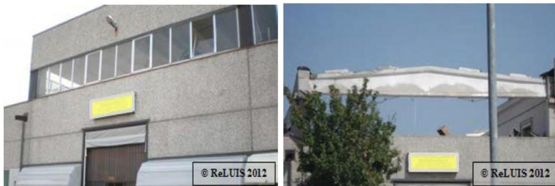
*Figura 20 - Pannelli orizzontali con nessun danno visibile a seguito della scossa del 20 maggio 2012 e collasso a seguito della scossa del 29 maggio*
