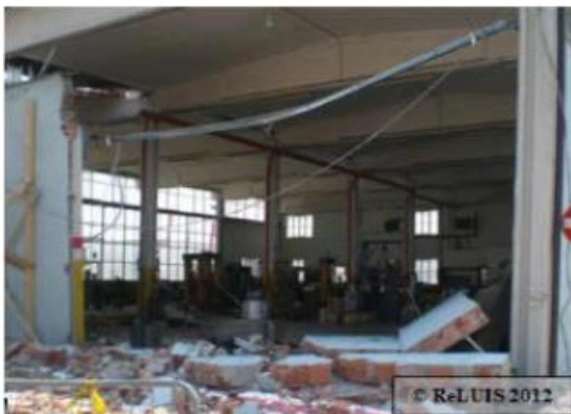
*Figura 23 - Collasso pannelli tamponatura in laterizio*
