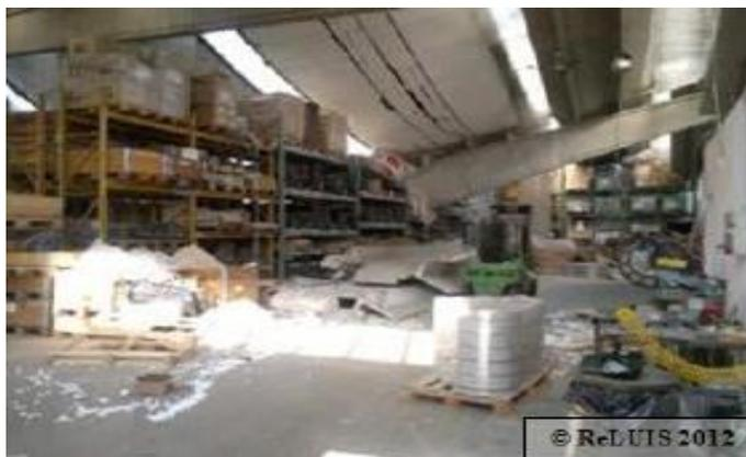
*Figura 15 - Perdita di appoggio dei tegoli che ha probabilmente causato il collasso della trave trasversale*
