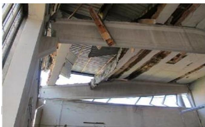
*Figura 14 - Perdita di appoggio della trave principale trasversale*
