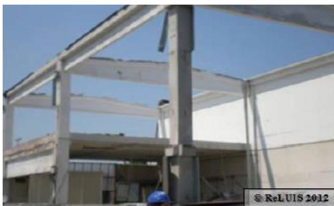
*Figura 16 - Collasso dei tegoli di copertura per perdita di appoggio*
