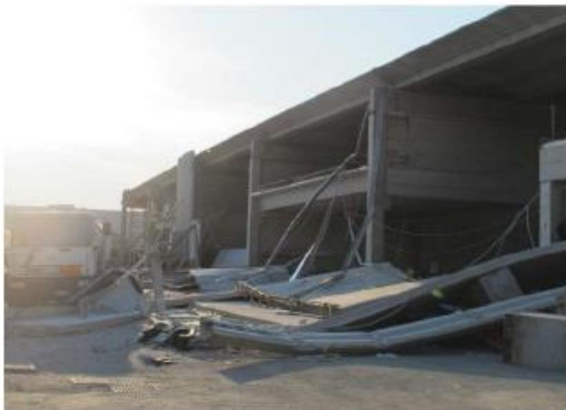
*Figura 22 - Collasso pannelli verticali di tamponatura*
