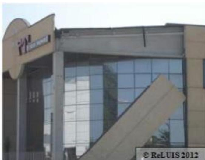
*Figura 21 - Collasso pannello di tamponatura orizzontale*
