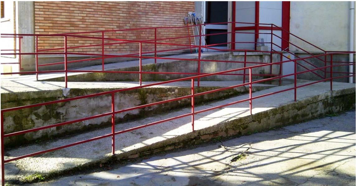
*Fig. 2.14 – Degrado rampe inclinate lato est*
