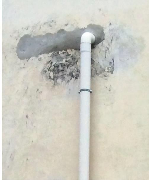
*Fig. 2.10 – Infiltrazioni d'acqua dal pluviale*
