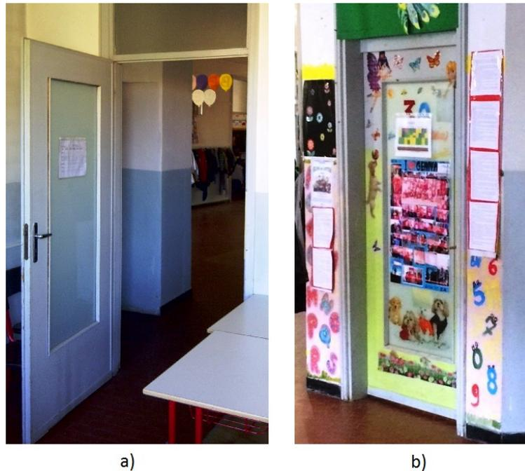
*Fig. 2.12 – Porte interne: semplice usura del tempo (a), sostituzione plexiglass con cartone (b)*
