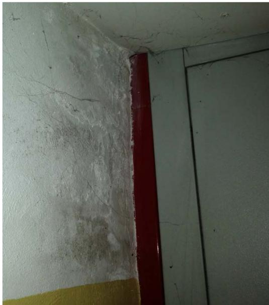
*Fig. 2.9 – Fenomeno di degrado dovuto a muffe*
