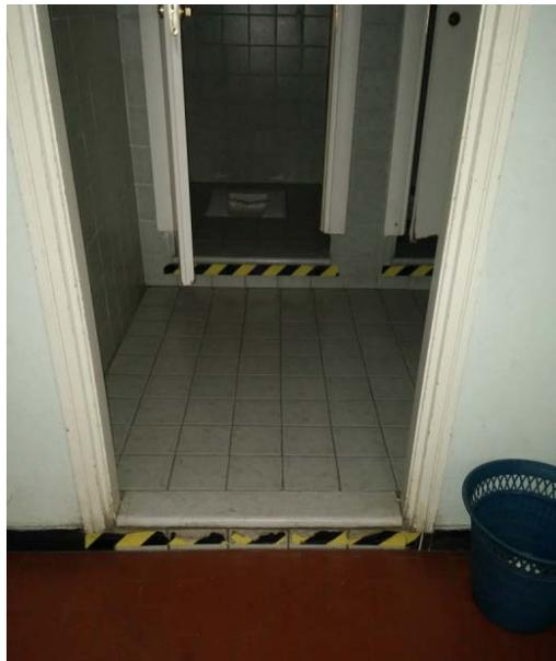
*Fig. 2.18 – Gradini di ostacolo per l'accesso ai servizi igienici*
