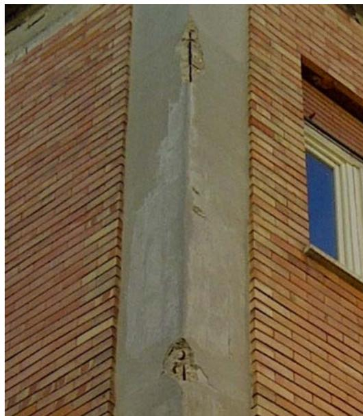
Fig. 2.8 – Elementi di degrado nelle strutture esterne
