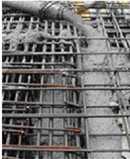
Riempimento di una struttura fortemente congestionata con SCC
