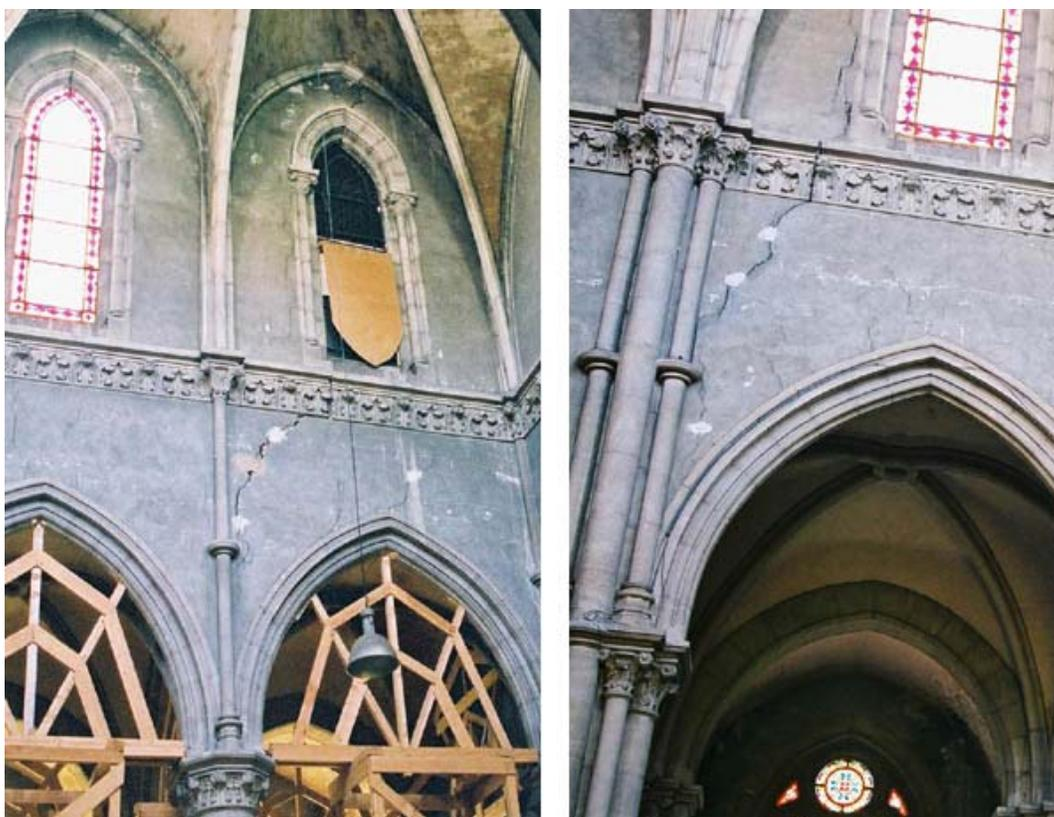
Una seconda tappa importante è stato il rilievo architettonico della chiesa e l'approfondimento dello studio dei materiali e delle strutture. Questa fase, oltre che finalizzata a preparare una base per il rilievo del degrado e dei dissesti e per l'individuazione delle relative cause, ha permesso di apprezzare il valore intrinseco della costruzione, realizzata applicando tecniche molto raffinate nei dettagli insieme a soluzioni innovative.
