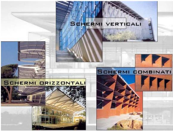
Negli esempi sopra riportati, l'effetto di ombreggiamento è ottenuto attraverso l'impiego di diverse tipologie di schermature solari; orizzontali, verticali e combinate.
