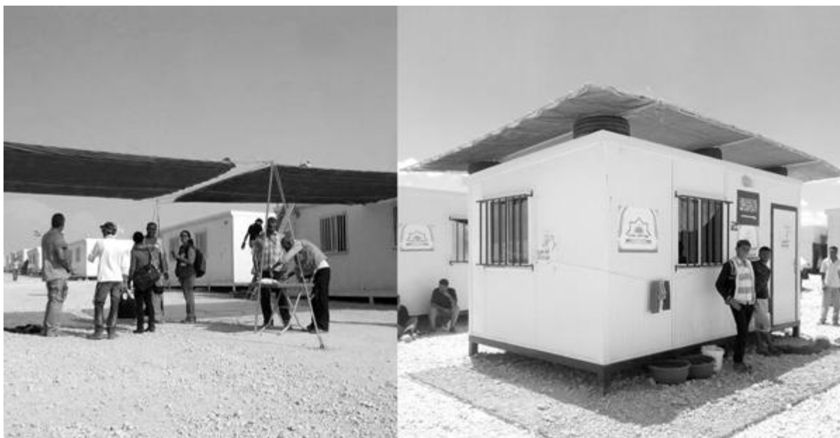
Shade roof e veranda. Prototipi dei kit realizzati a Zaatari da un implementing partner di UNHCR
