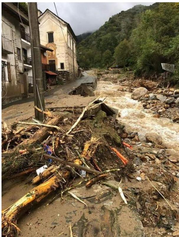
**Figura 55 :** Ulteriore vista sull'abitato di Corte, visibile l'entità dell'erosione spondale e dell'alveo, oltre ai danni alle infrastrutture e materiale ligneo trasportato dalla piena. ([www.cittadinovara.com](http://www.cittadinovara.com)).
