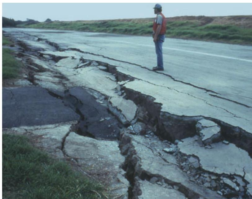
**Figura 13:** *Danno per espansione laterale risultato del terremoto di Loma Prieta, California, USA, 1989n (Photograph by Steve Ellen, U.S. Geological Survey).*
