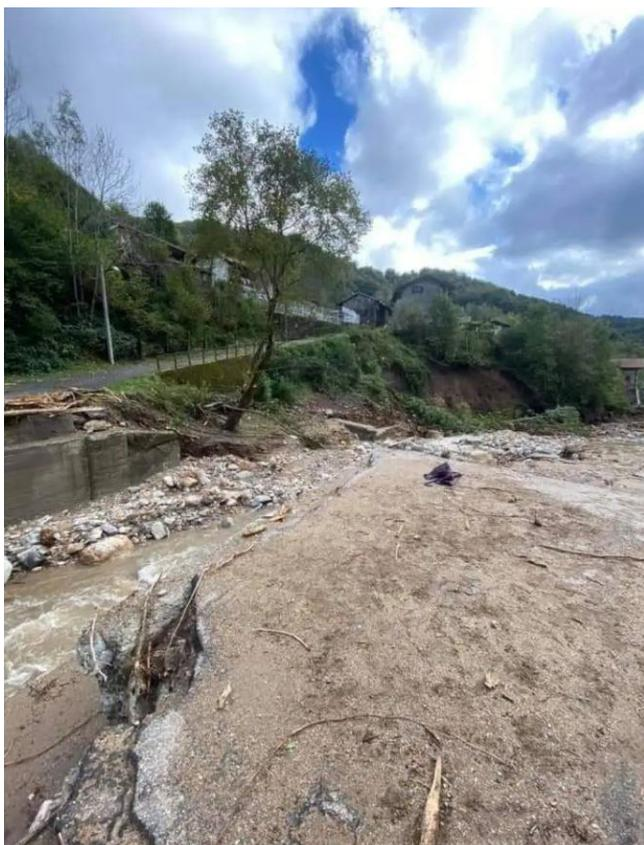
**Figura 53:** *Uno dei due ponti carrabili crollati e successivamente asportati per effetto della pressione dell'ondata di piena; (www.cittadinovara.com).*
