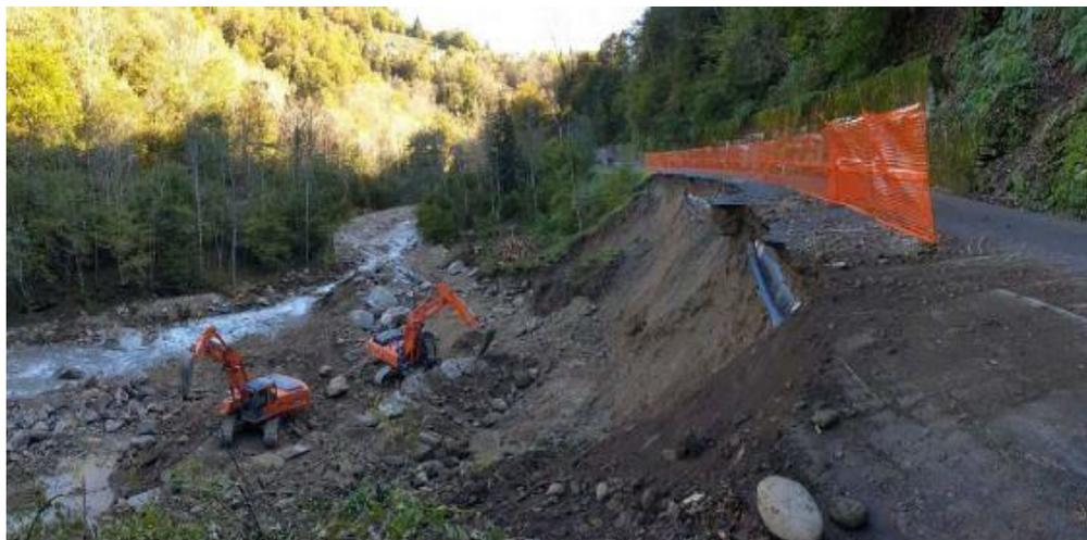
**Figura 52:** *Sottoescavazione della strada di accesso a Camasco per erosione da parte del torrente Nono; (Rapporto evento 2-3 Ottobre ARPA).*
