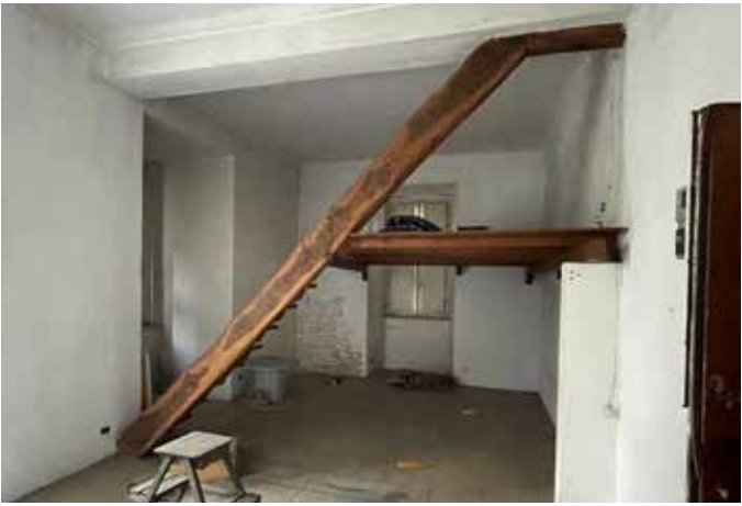
F1 - Cavalletto, che sorregge in muro di tramezzo
