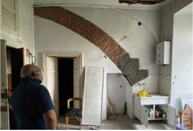
F2 - Arco scaricatore del 2° piano
