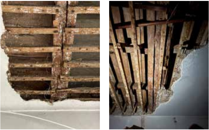
F3 - Solaio in legno del corpo principale
