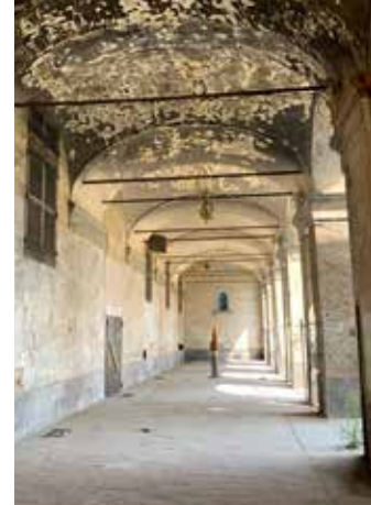
Vp - Il portico coperto da una serie di volte a vela e volte a botte ribassate con le catene
