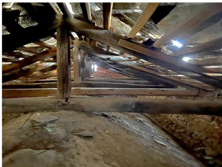
La struttura in capriate lignee a sostegno del manto di copertura in lose della chiesa.
