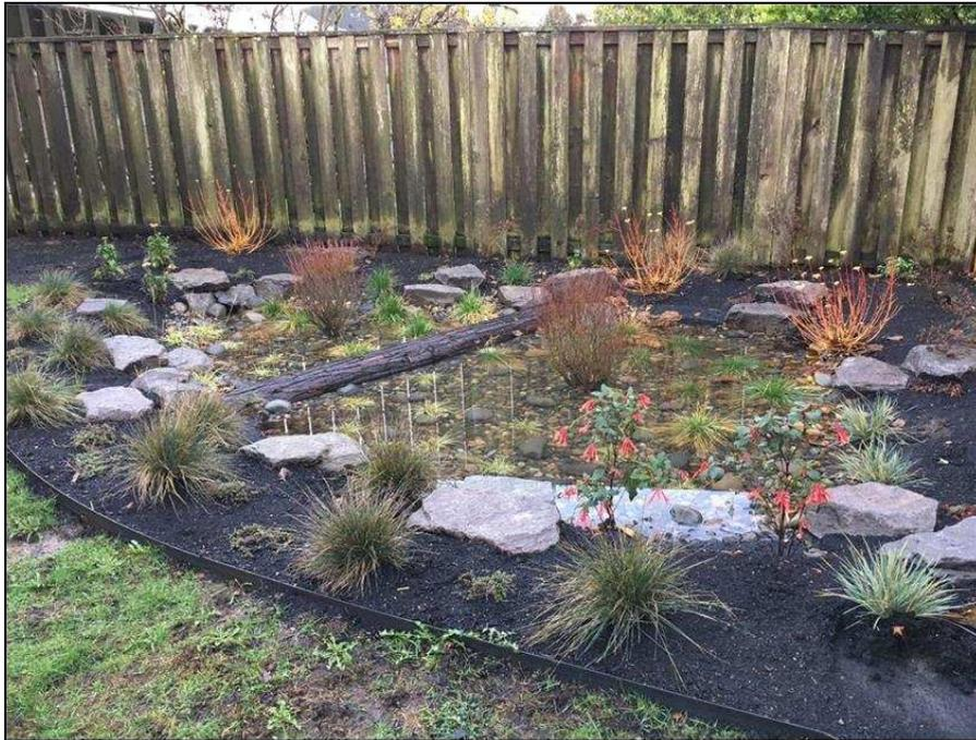
Figura 23: Esempio di Rain garden. Fonte: Storm Water Management (SWMM)
