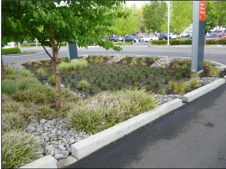
Figura 24: Esempio di bacino realizzato a Portland. Fonte: Storm Water Management (SWMM)
