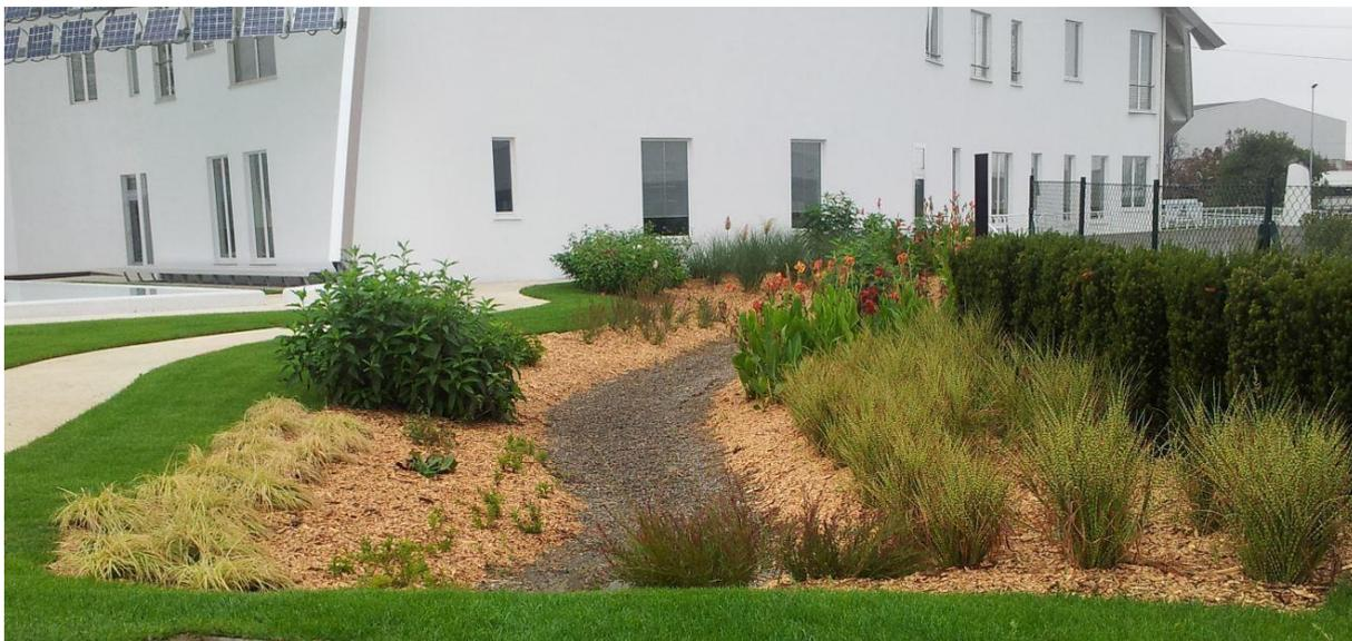
*Figura 53: Area di bioritenzione vegetata presso il centro ricerche Kerakoll (Sassuolo - MO), progettata da IRIDRA. in collaborazione con BIOS-IS S.r.l. Fonte: Sito <http://www.irdra.eu/it/suds.html>*
