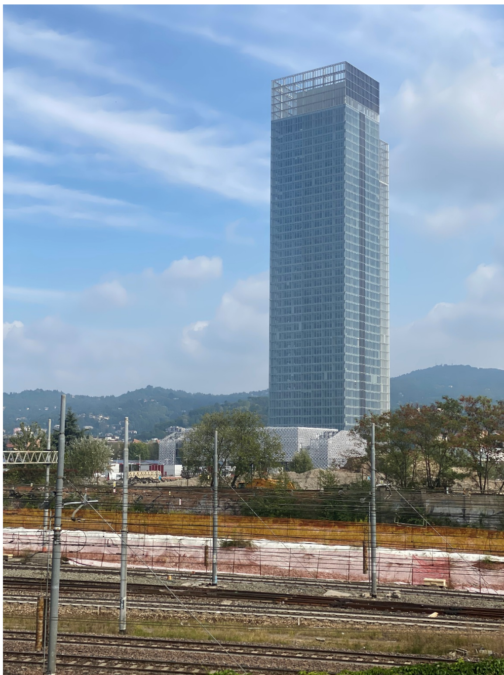
Figure 3 - Fotografia del PSRI, l'edificio fotografato è il palazzo della regione nel comprensorio 2.
