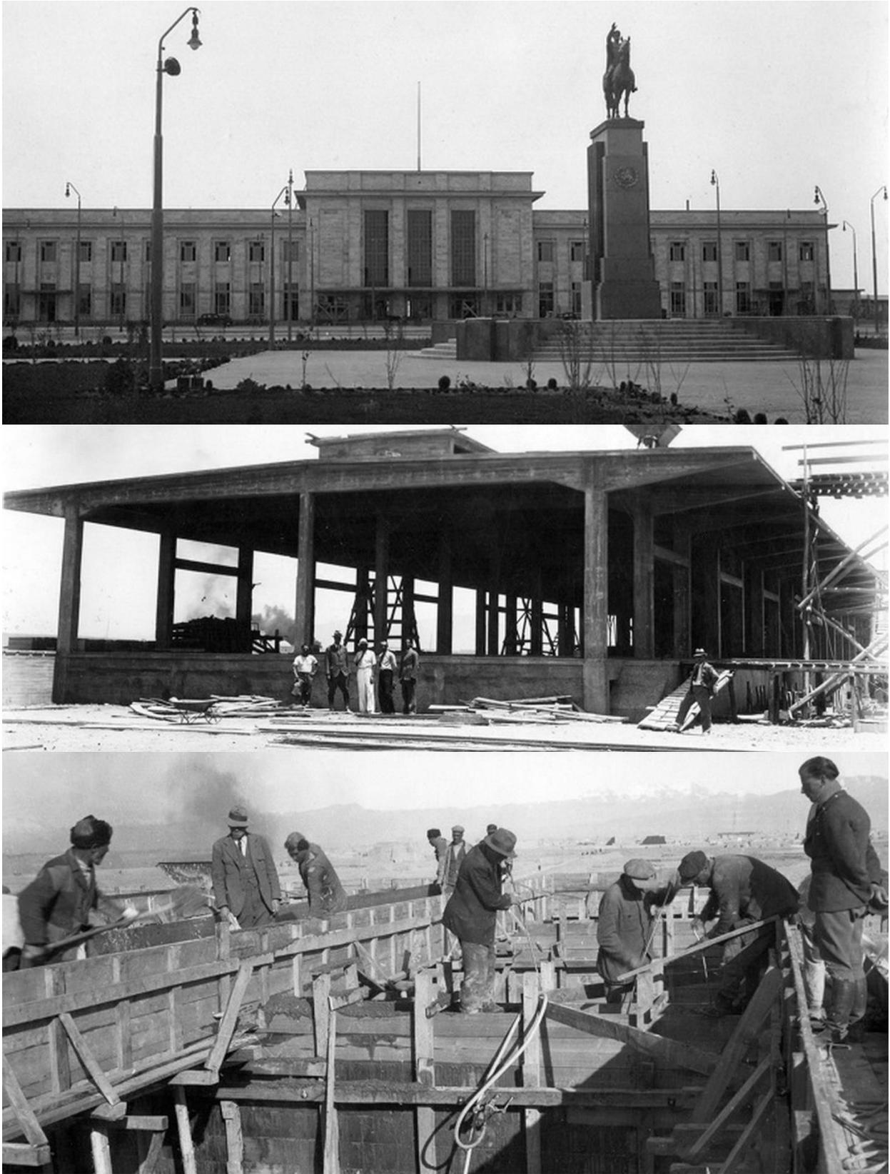
**Figura 12** La costruzione della stazione ferroviaria di Tehran ad opera della ditta tedesca Philipp Holzmann, 1935-36.
