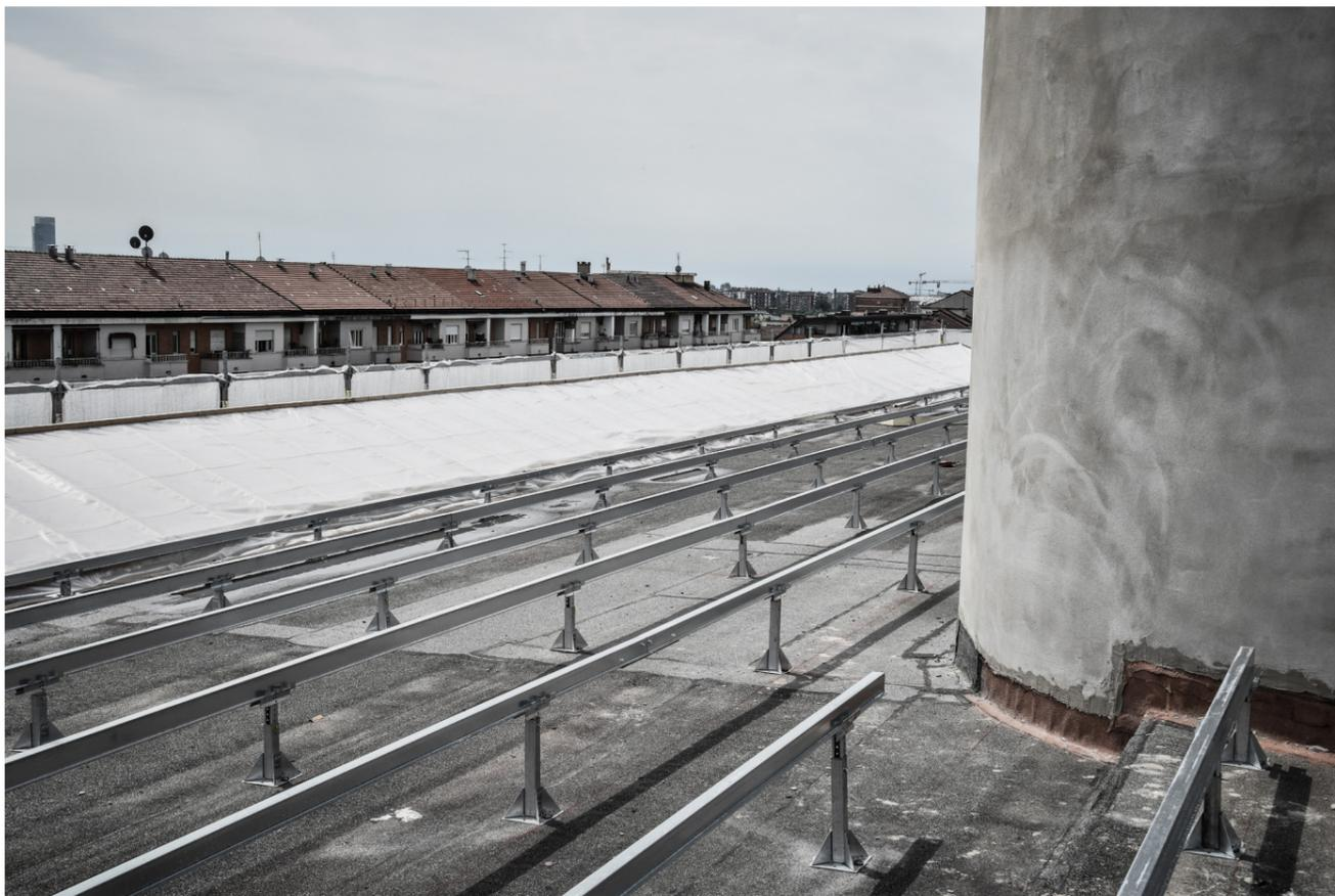
**Figura 6:** Risanamento della guaina impermeabilizzante ammalorata e prima fasi di montaggio dei sostegni per la copertura ventilata.
