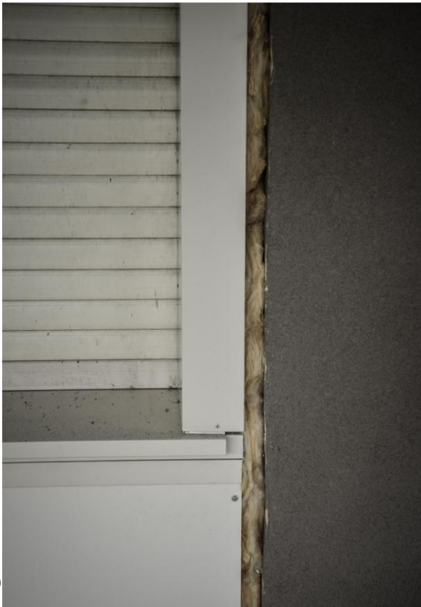
**Figura 3:** Posa dell'isolante poliuretano da 12 cm tramite incollaggio e fissaggio finale con tasselli plastici.
