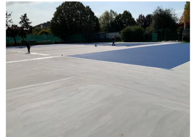
**Fig.32** Fase 1: stesura sottofondo e prima mano verniciatura [ottobre 2019]
