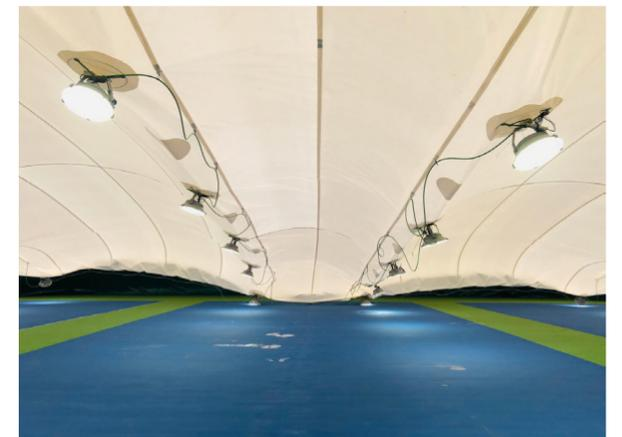
**Fig.34** Fase 3: montaggio pallone pressostatico e corpi illuminanti a induzione magnetica [novembre 2019]
