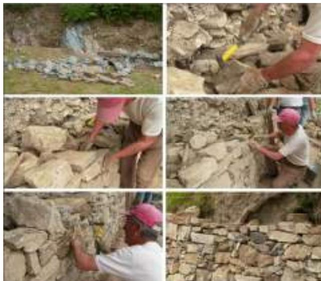
Fig. 2.14 Fasi di costruzione muro a secco: 1)fondazione; 2)lavorazione pietre; 3)posizionamento pietre; 4-5)inserimento scaglie; 6)corso ultimato. (fonte: Cantiere scuola Arnasco)
