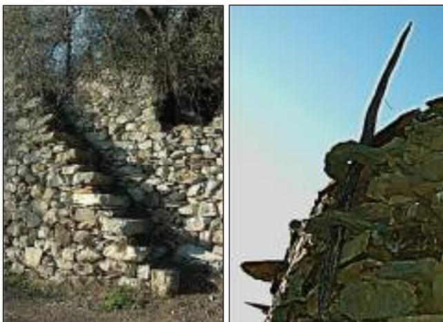
Fig. 2.15 Scala e sostegno viti in muro a secco
