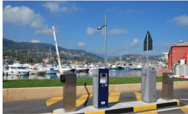
Figura 15: Portale RFID per l'accesso veicolare
