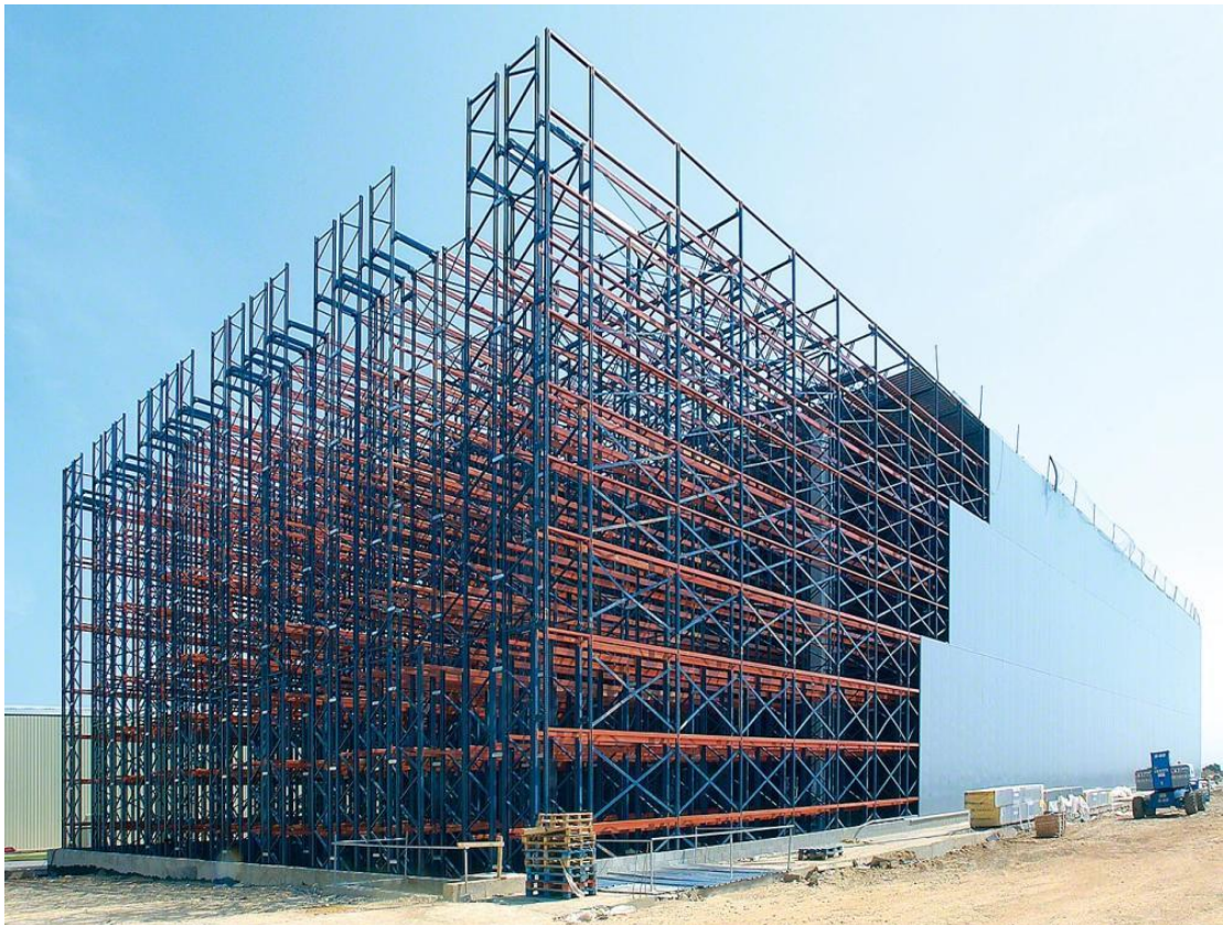
Figura 20. Immagine di un magazzino automatico autoportante tratta da www.mecalux.it
