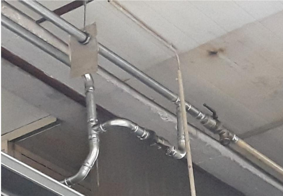
*Figura 47 - Ampliamento rete aria compressa capannone nuovo*
