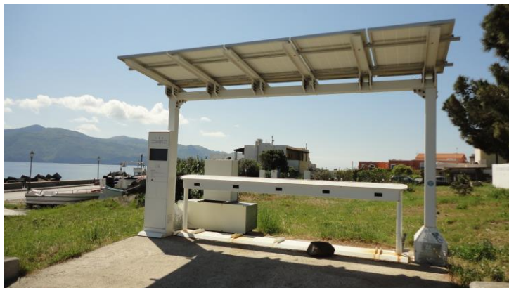
Figura 31- pensiline fotovoltaiche per biciclette a pedalata assistita [43]
