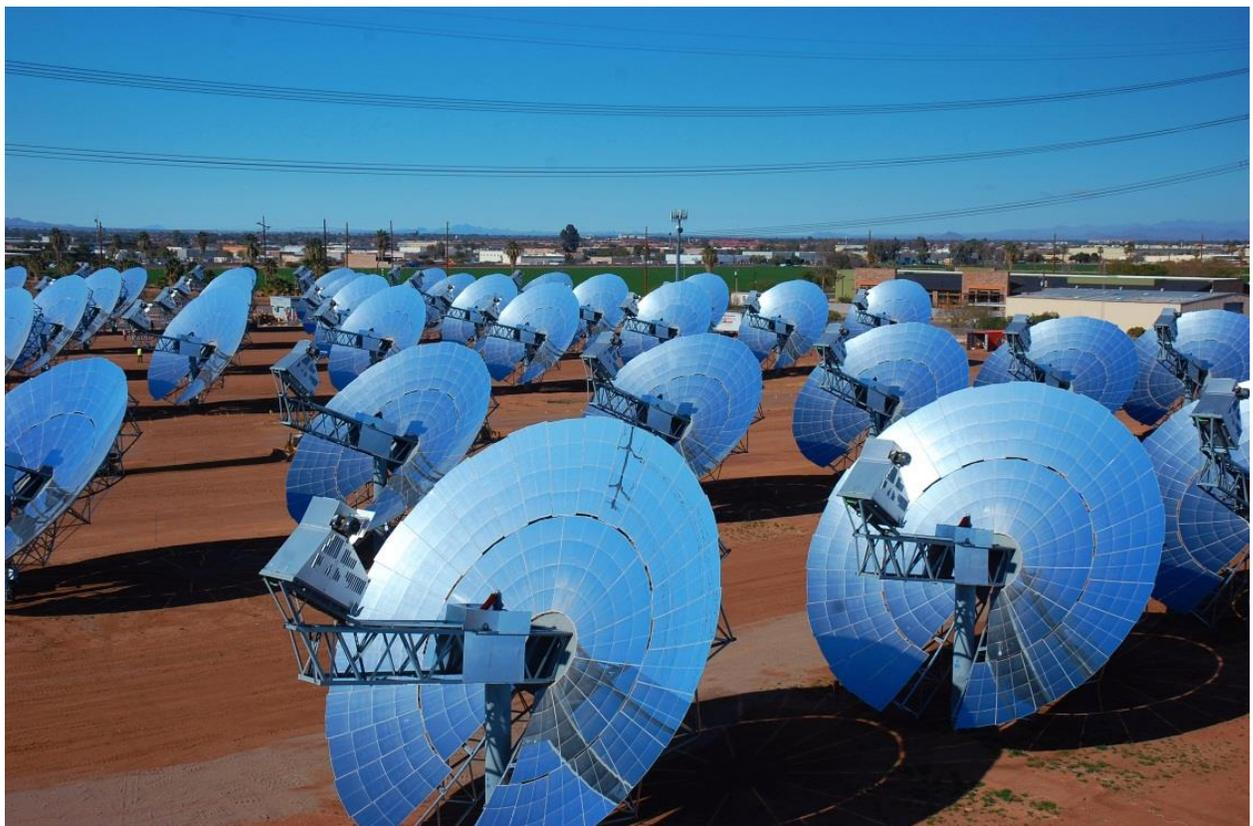
*Figura 1.9 - Campo di collettori parabolici a disco in Arizona, USA [8].*
