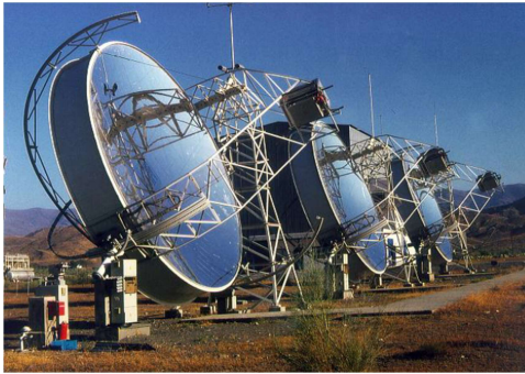
(a) Configurazione collettore solare con membrana unica
