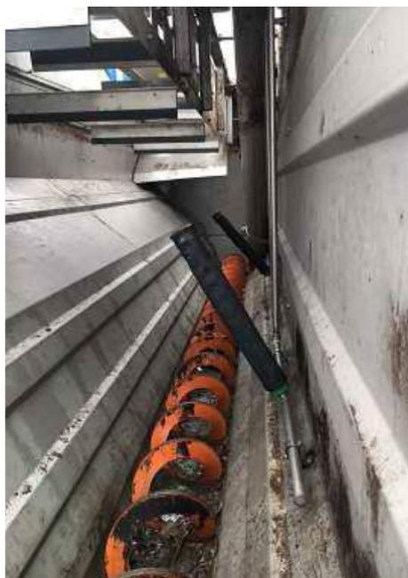
**Figura 8.2.3.5:** Esempio di dissabbiatore areato.
