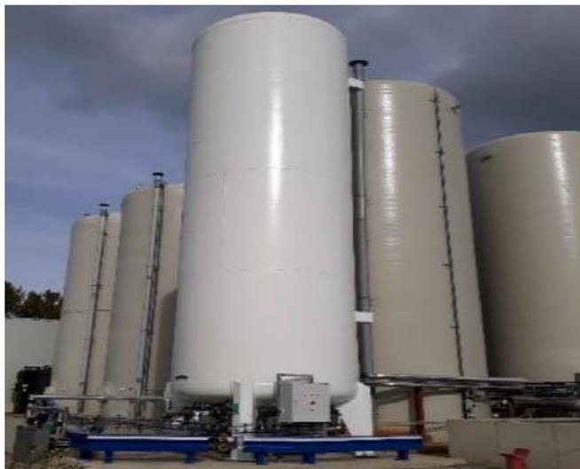
**Figura 8.4.5.2:** Esempio di serbatoio verticale di stoccaggio CO<sub>2</sub> liquida.
