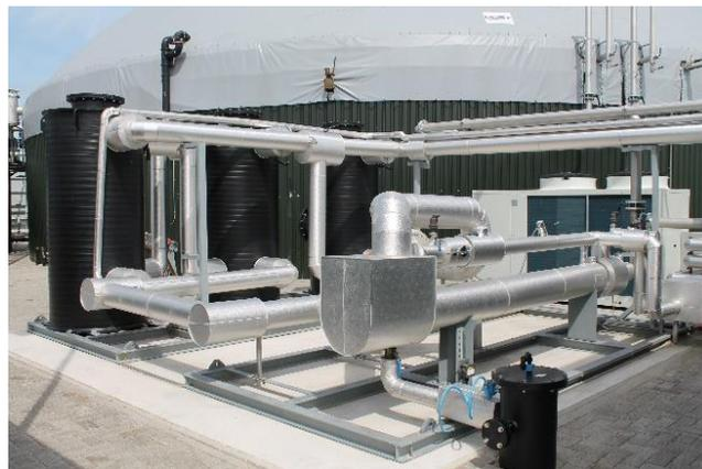
**Figura 8.4.3.1:** *Chiller* del biogas.
