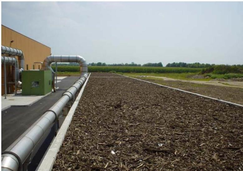
**Figura 8.9.1.3:** Esempio di biofiltro.
