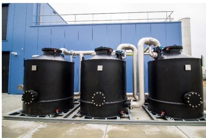
**Figura 8.4.3.2:** Sistema di filtrazione del biogas.
