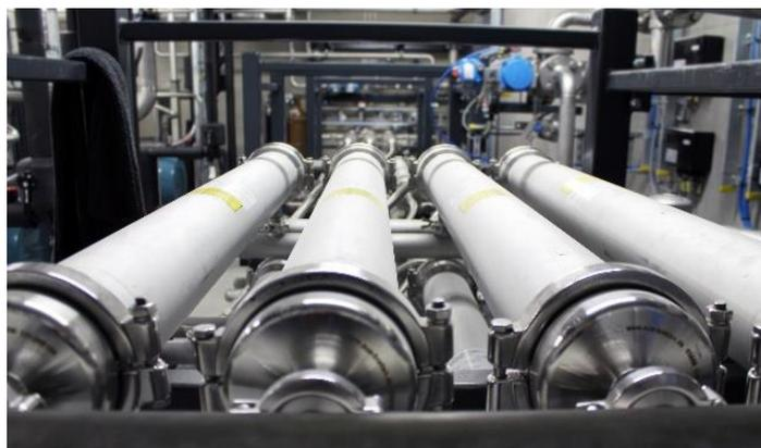
**Figura 8.4.4.4:** Moduli di membrane all'interno di un container.
