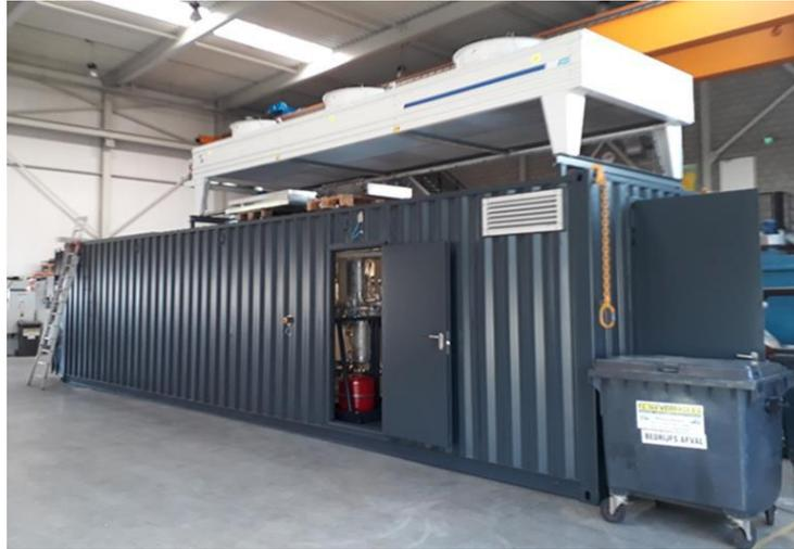
**Figura 8.4.3.3:** Compressore biogas in container da 12 metri.
