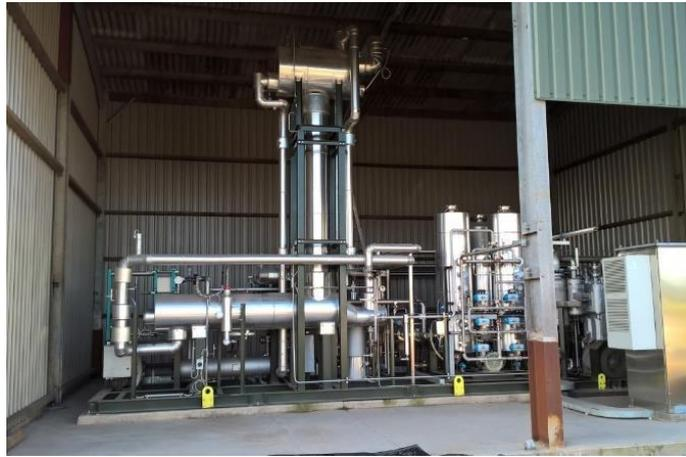
**Figura 8.4.5.1:** Unità di liquefazione della CO<sub>2</sub>.
