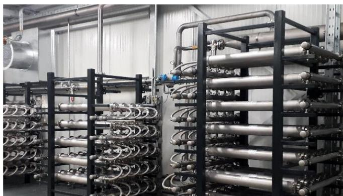
**Figura 8.4.4.3:** Moduli di membrane all'interno di un prefabbricato.
