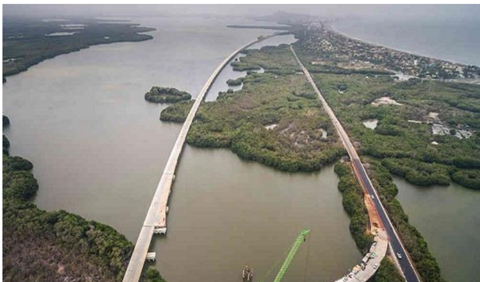
Figure 5. Viaducto construido sobre la Ciénaga de la Virgen, Colombia. Recuperado de: Periodico El Universal
