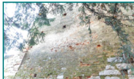
Particolare della muratura mista alla base della Torre nel prospetto Nord
