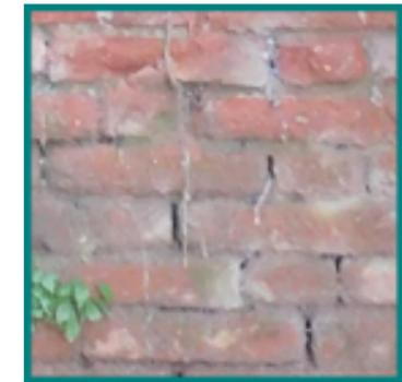
Dettaglio del fronte di risalita nel prospetto Nord della Torre
