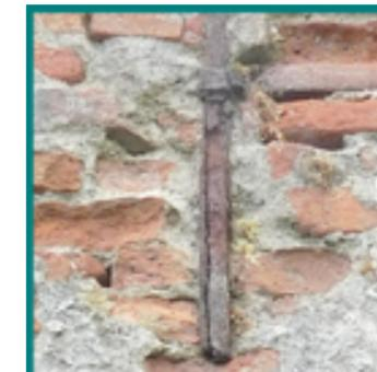
Dettaglio barre metalliche delle colonne del Ninfeo
