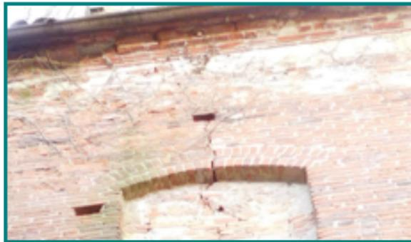
Particolare della parte superiore del prospetto Nord caratterizzato da disgregazione
