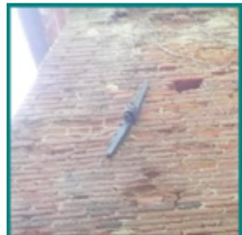
Dettaglio capochiavi in ferro in corrispondenza delle catene inserite all'interno della torre
