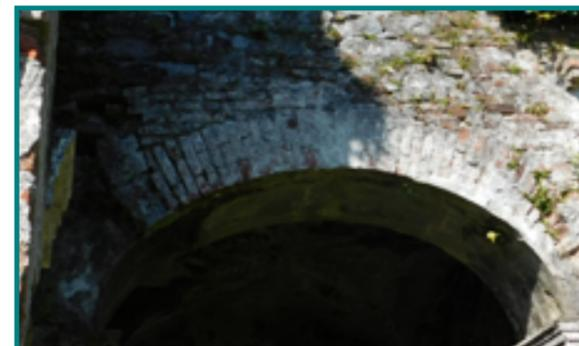
Particolare dell'arco laterale destro in cui emerge l'effetto della disgregazione dell'intonaco
