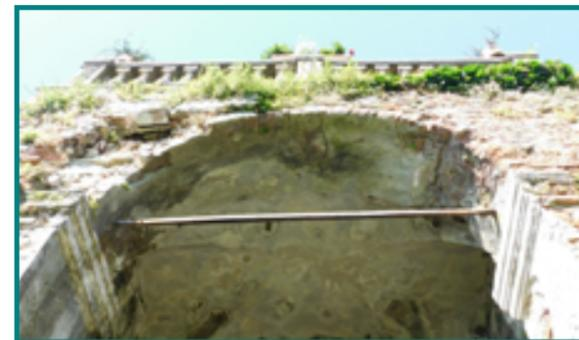
Vista di dettaglio del prospetto Ovest del Ninfeo in cui si nota la presenza di catene
