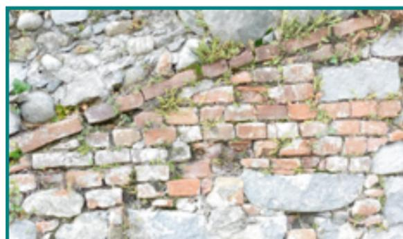
Dettaglio muratura delle rampe di accesso al giardino terrazzato in cui si riscontra la presenza di laterizi
