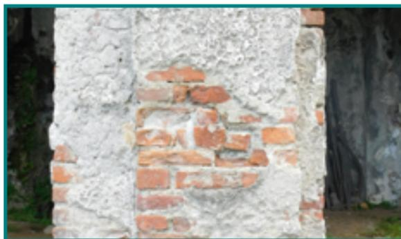
Particolare delle colonne del Ninfeo in cui emerge la presenza di degradazione differenziale
