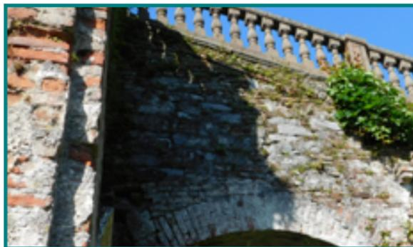
Dettaglio prospetto Ovest del Ninfeo in cui emerge la presenza di colonizzazione biologica
