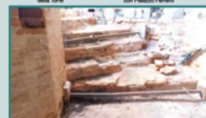
Dettaglio delle scalinate della parte sommitale in avanzato stato di degrado
