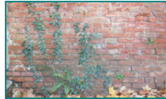
Particolare del prospetto Nord della Torre in cui emerge il fenomeno del fronte di risalita
