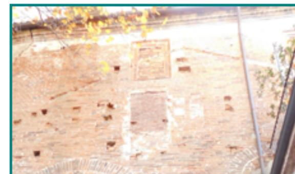
Particolare del prospetto Nord della Torre in cui emerge la mancanza di materiale
