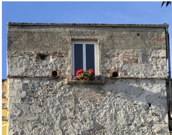
Fotografia della sopraelevazione in laterizio della torre angolare.
