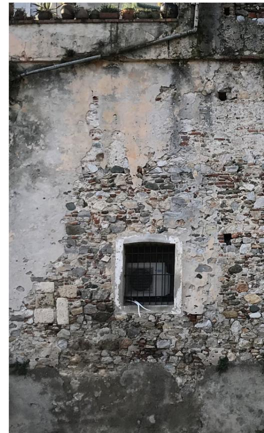
Porzione di muratura lapidea con inserti in laterizio, emergente dalle lacune della superficie intonacata.
