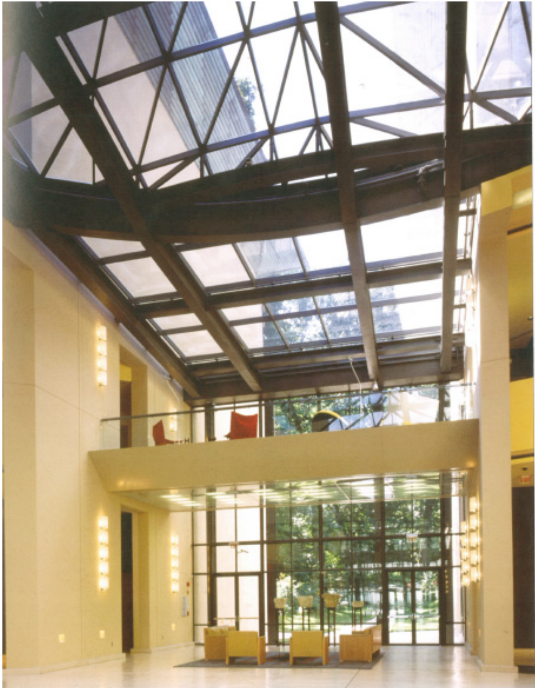
Gaetano CORTESE, Il Palazzo sul Potomac. L'Ambasciata d'Italia a Washington , Stabilimenti Tipografici Carlo Colombo S.p.A, Roma, prima edizione 2011, seconda edizione 2014, p.161. Parete vetrata di fronte al parco, davanti a cui, all'interno, sono collocati dei resti archeologici, che contrastano con il moderno degli ambienti interni dell'edificio.
