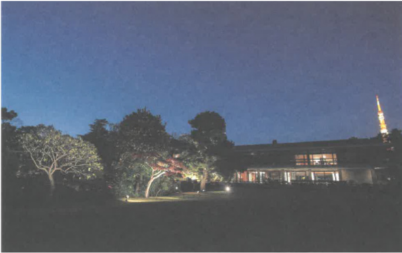
Edito da Ambasciata d'Italia a Tokyo, Ambasciata d'Italia a Tokyo , Sangensha Publishers Inc., 2016, p.65. Vista notturna della facciata Sud della Residenza.
