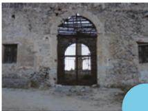
Archi di scarico che si alternano a lle volte. Sono formati da mattoni disposti a corsi regolari ortogonali al manto nella direzione dei raggi. I laterizi che compongono l'arco sono disposti di testa e di piatto.
