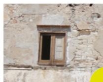
Serramenti, o riginariamente composti da un telaio fisso ed un telaio mobile in legno
