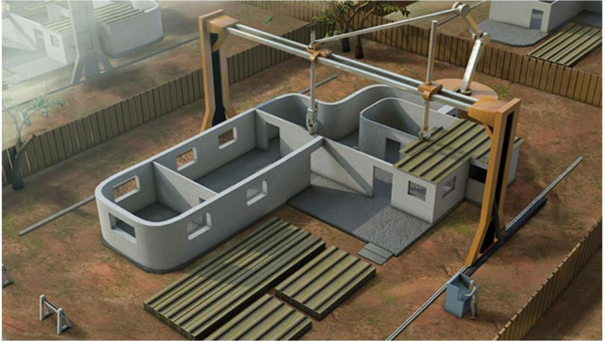
*Figura 40: esempio costruzione 3D con tecnologia FDM*
