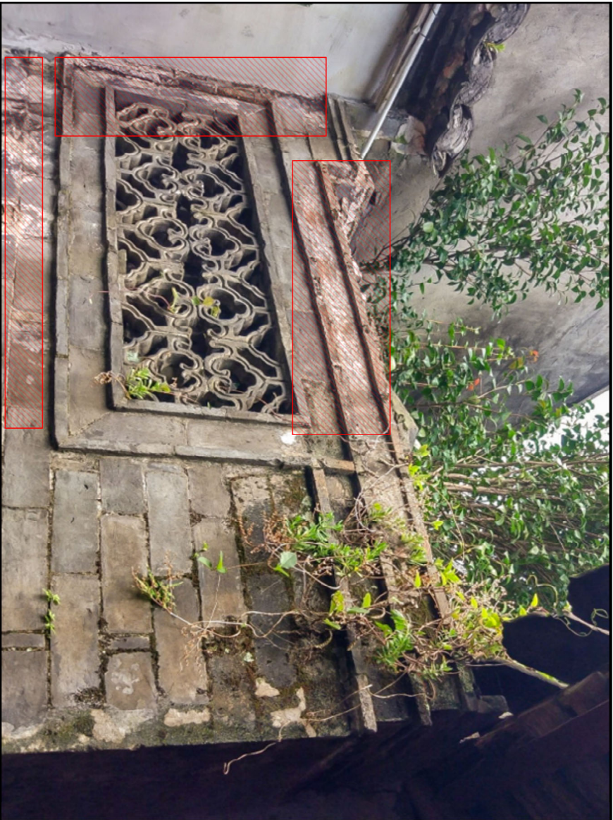
EVIDENZA DI FENOMENI DI EFFLORESCENZA
