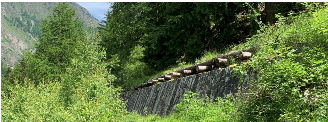
Figura 7.2.1 Esempio di ripristino del canale eseguita con esito positivo.
