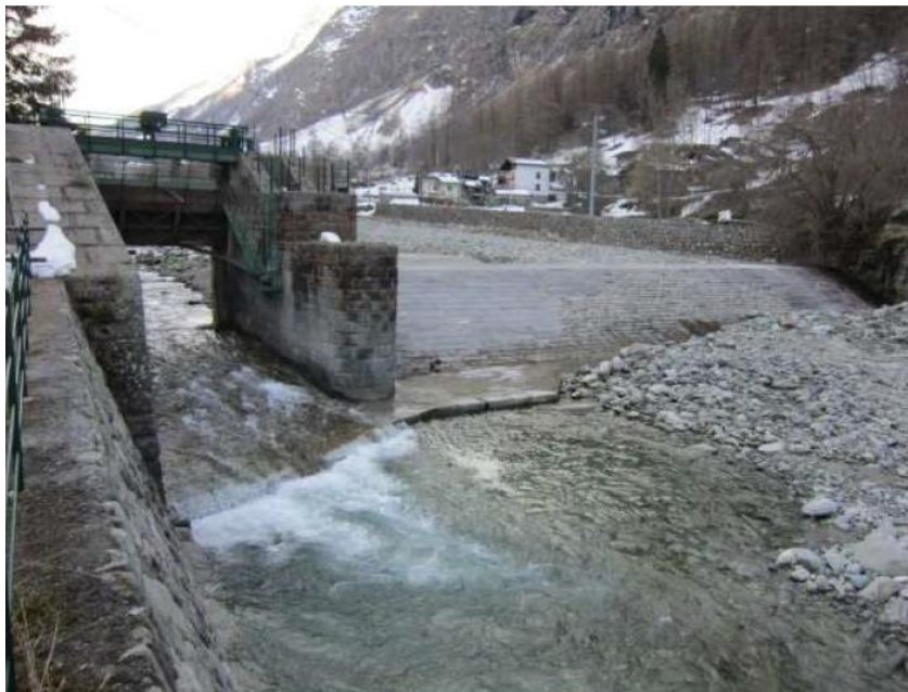
Figura 2.6 Opera di presa vista da valle.
