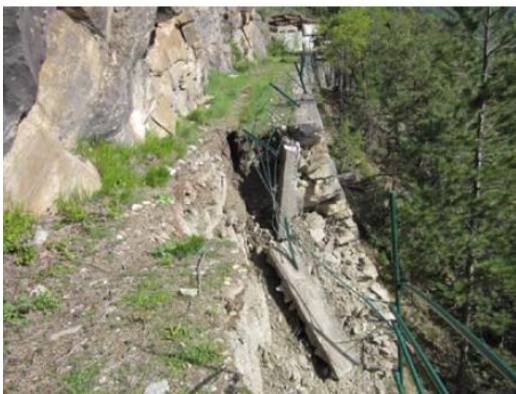
Figura 3.2.9 Cedimento muro in loc. Perreya (Villeneuve) maggio 2013 (Ramo Collettore)
