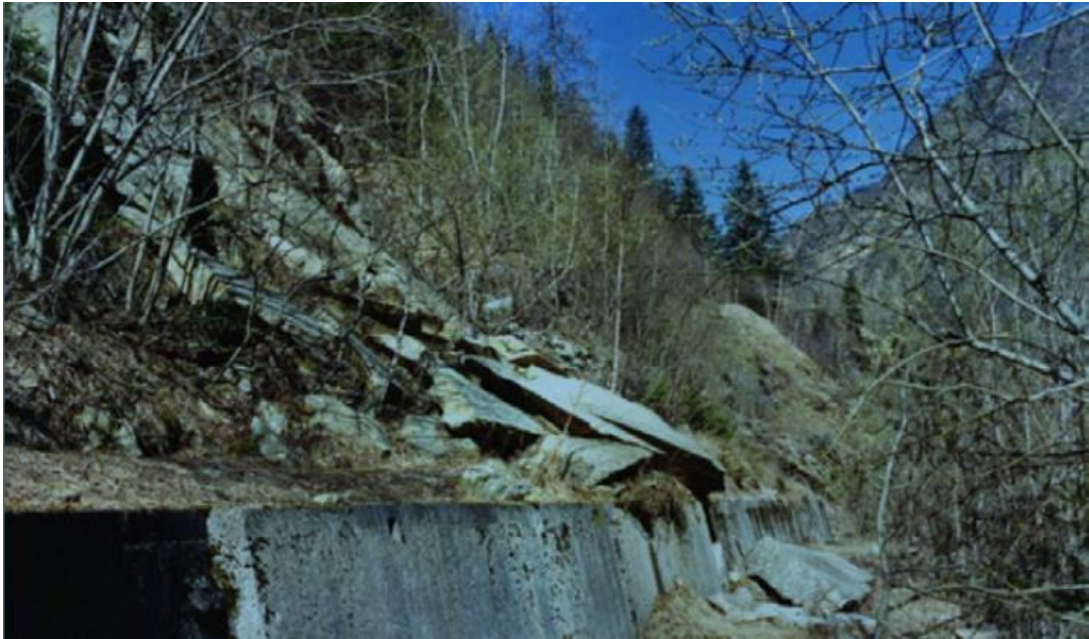
Figura 3.2.4 Frana di crollo a La Nouva (Aymavilles) del 2 maggio 1996 (Ramo La Nouva)
