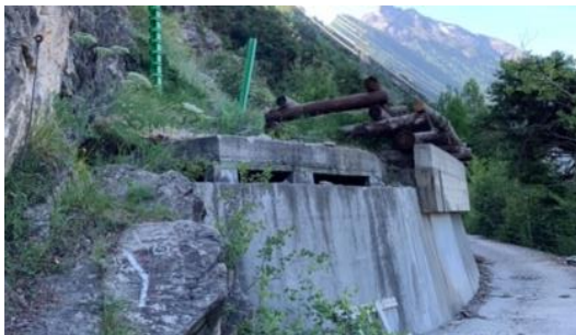
Figura 5.1.3 Sistema di copertura con tronchi.
