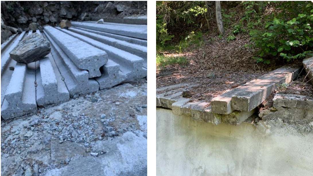
Figura 5.1.4 Sistema di copertura con travetti.
