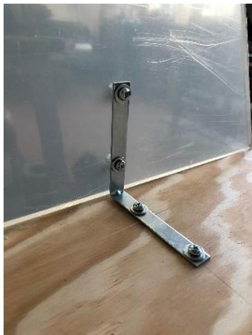
*Figura 48: Squadretta angolare per il fissaggio delle sponde*
