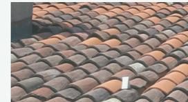
Copertura con struttura lignea e rivestimento in coppi moderni.
