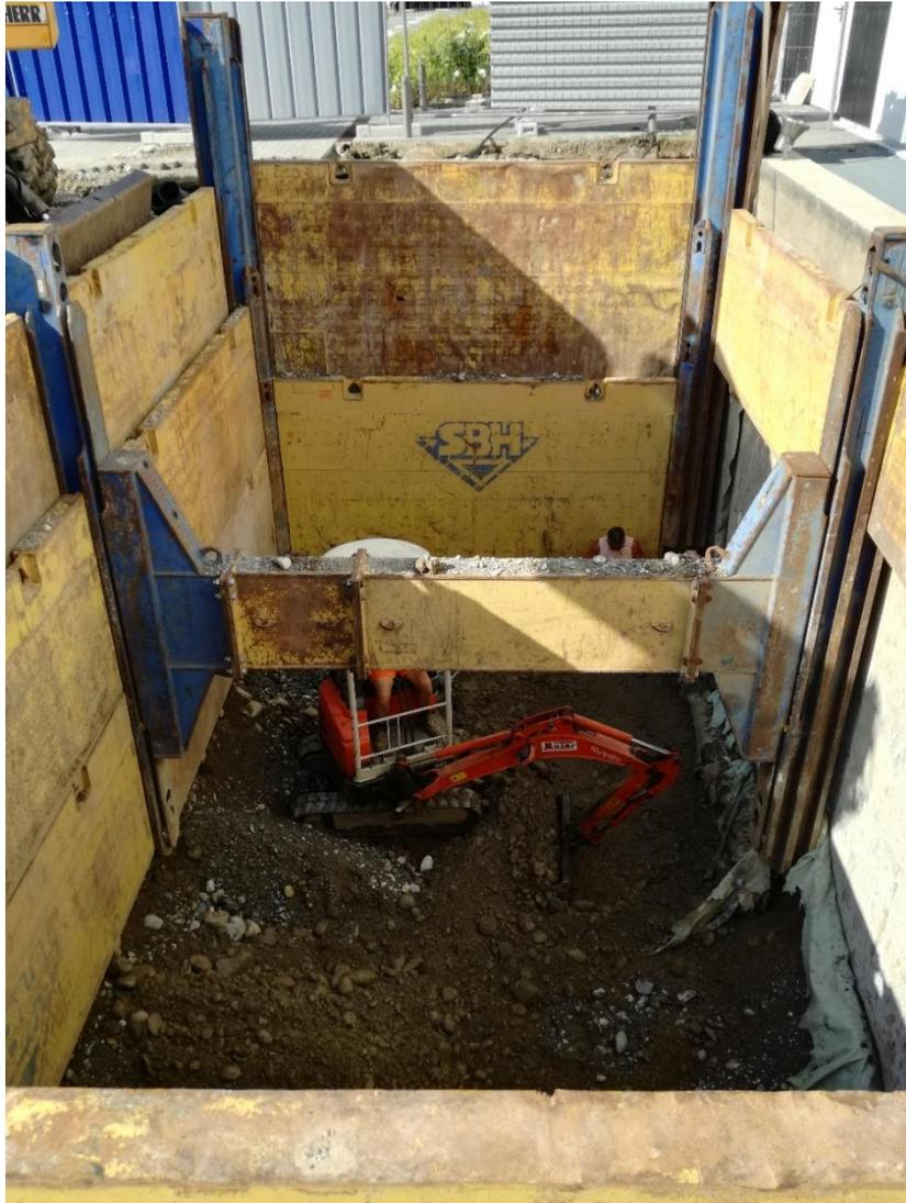
*Figura 29 – Armatura di scavo*
