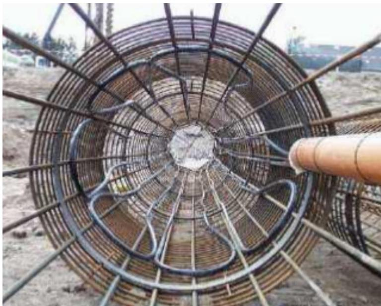
Figura 23 – Schema di tubi scambiatori di calore fissati alla gabbia di armatura di un palo energetico di fondazione (Brandl, 2006)
