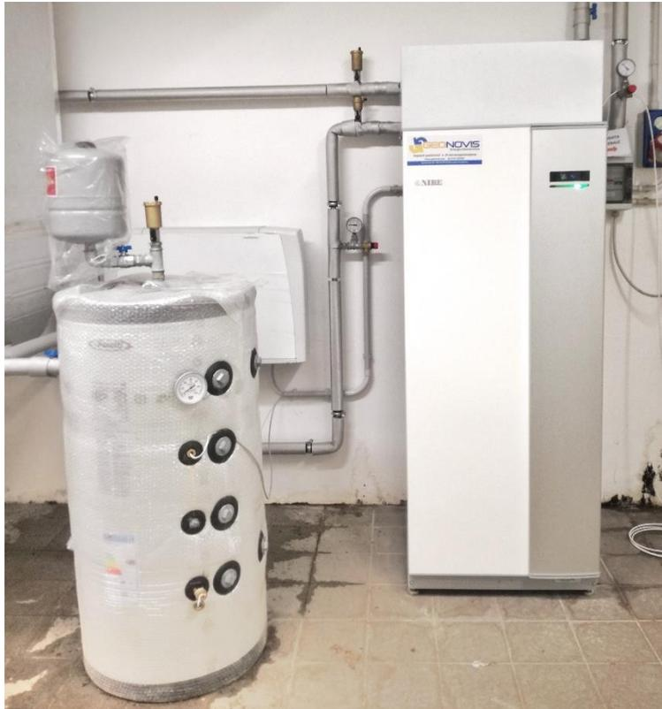
*Figura 47 – Pompa di calore geotermica NIBE F1155*
