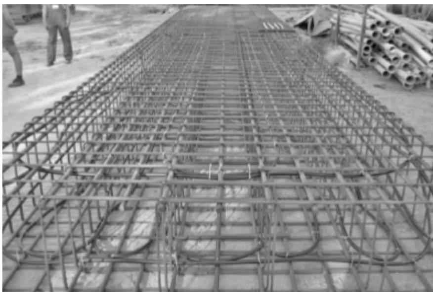
*Figura 26 – Schema di armatura di un diaframma energetico e tubazioni di scambio di calore (Brandl, 2006)*
