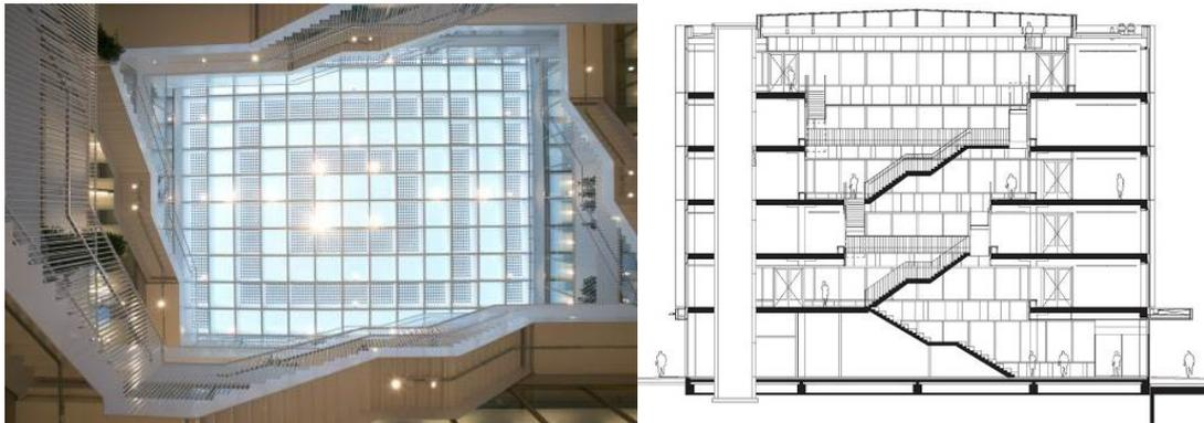
图 4.31 Polak 大楼井字形网格结构的采光屋顶
