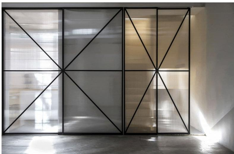
图 4.42 阳光板轻钢隔断
