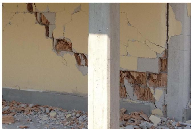
**Figura 1.12:** Esempio di danneggiamento provocato dallo schiacciamento degli spigoli di un tamponamento in muratura causato da un evento sismico [8]
