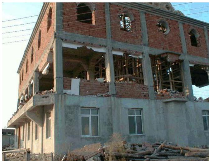
**Figura 1.14:** Esempio espulsione fuori piano dei tamponamenti in muratura provocato da un evento sismico - Izmit, Turchia (1999) [16]
