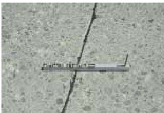
FIGURA 32 - OSTRUZIONE DEL GIUNTO
