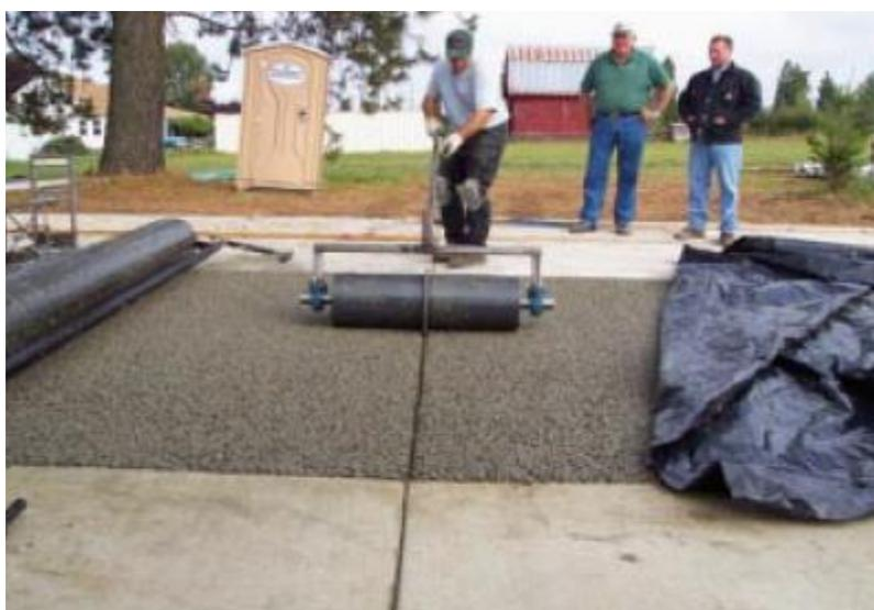
FIGURA 17 - REALIZZAZIONE DEL GIUNTO
