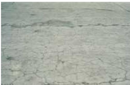
**FIGURA 34 - FESSURAZIONE A "PELLE DI COCCODRILLO"**
