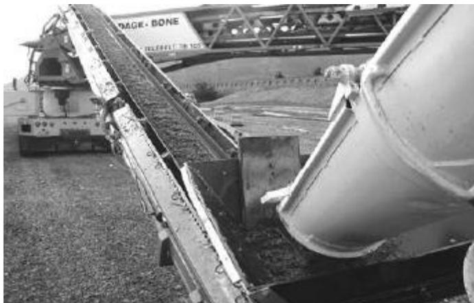
**FIGURA 14 - SCARICO ATTRAVERSO NASTRO TRASPORTATORE**
