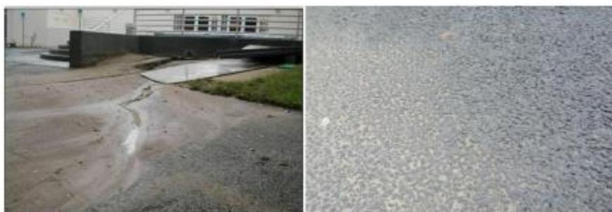
FIGURA 19 - ESEMPI E CONSEGUENZE DELL'INTASAMENTO DELLA PAVIMENTAZIONE
