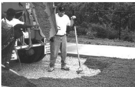
FIGURA 13 - SCARICO DIRETTO DALLA BETONIERA
