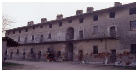
*Figura 23- Scala interna e ballatoio, elementi di collegamento tra i vani abitativi.*
