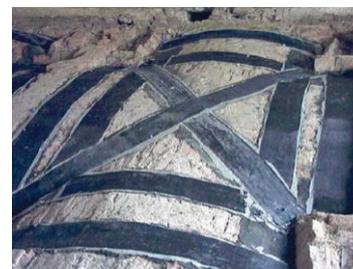
*Figura 84-Esempio di rinforzo delle volte con l'utilizzo delle fibre di carbonio.*
