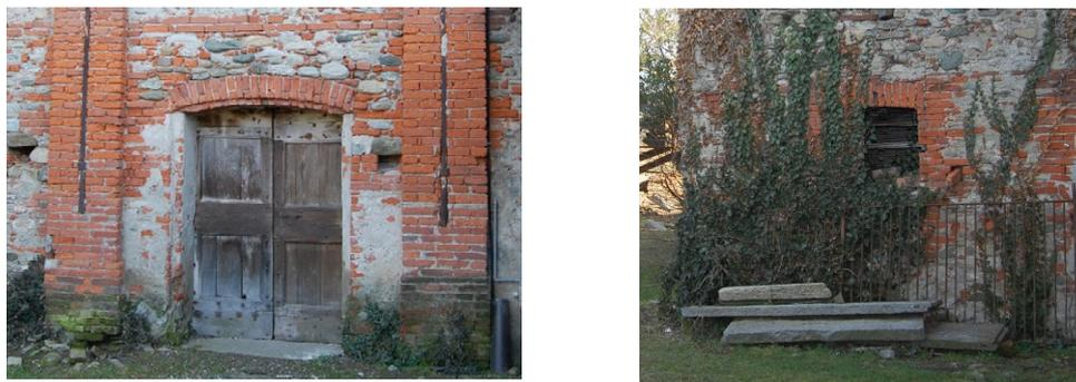
*Figura 72-Degradi presenti nel prospetto nord.*
