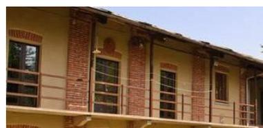
Figura 64-Ballatoio, elemento di collegamento orizzontale tra i diversi vani abitativi.
