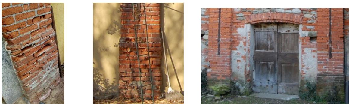
Figura 78-Degradi presenti nei pilastri portanti.
