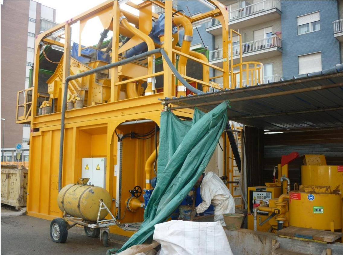
*Figura 94 – Impianto di separazione e impianto di miscelazione posti a ridosso del container di guida*
