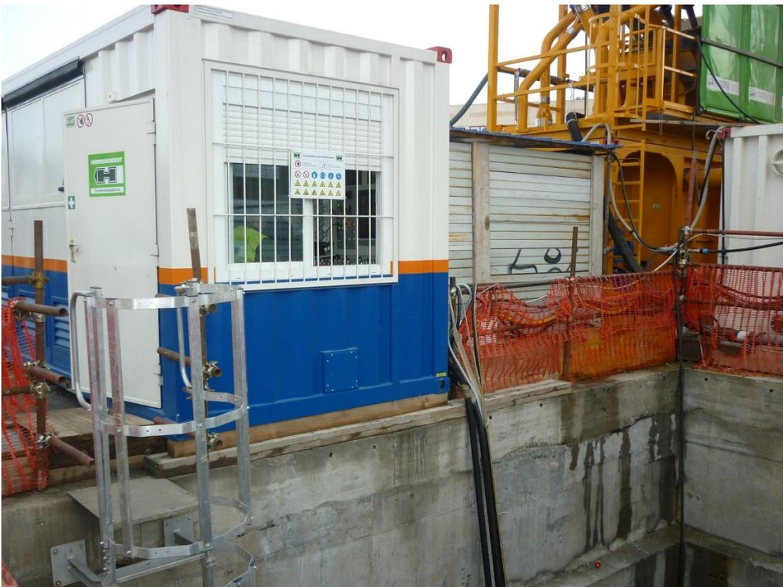
Figura 74 – Container di guida posizionato immediatamente a ridosso del pozzo di spinta P2-15
