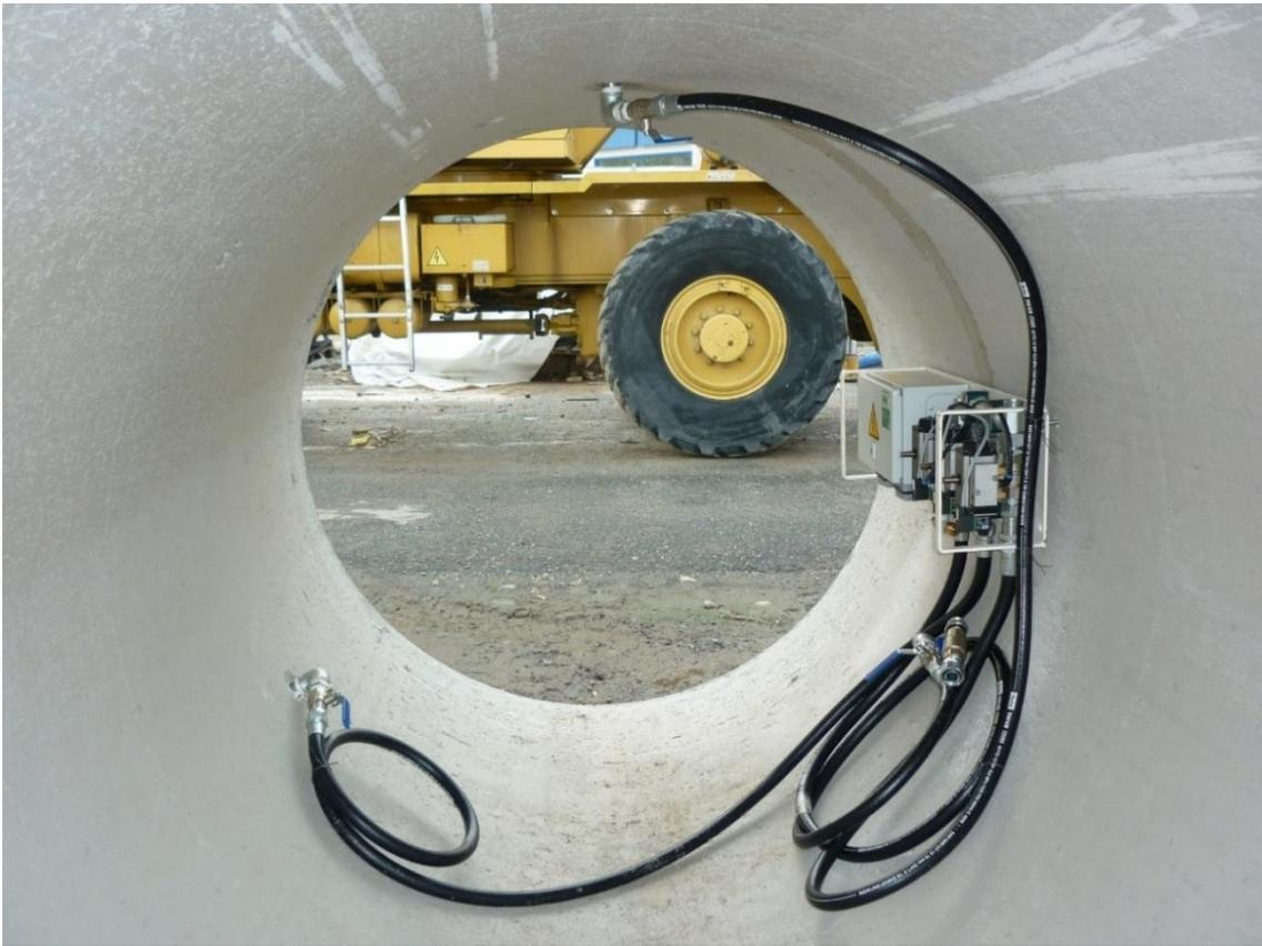
Figura 77 – Vista interna dei tubi dotati di tre valvole per effettuare la retroiniezione di bentonite
