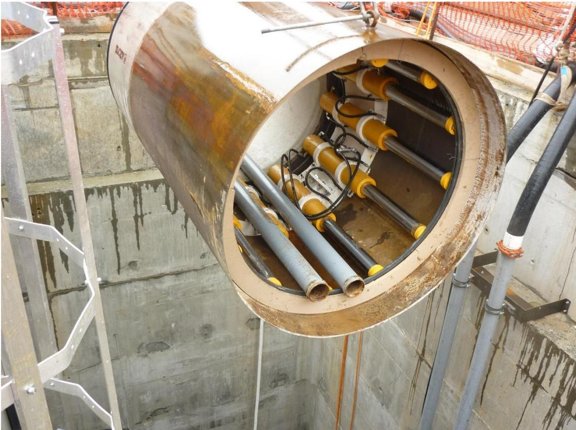
*Figura 86 – Movimentazione ed installazione per mezzo di gru mobile semovente della stazione di spinta intermedia*
