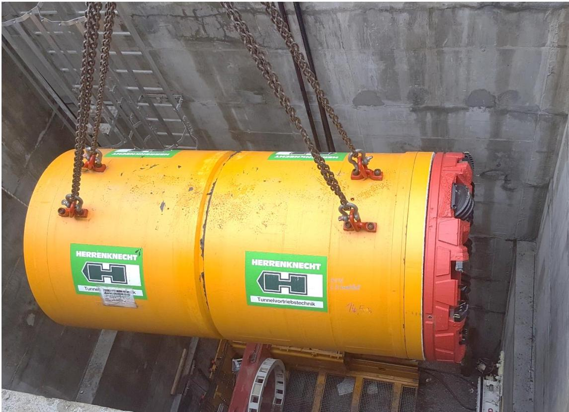
Figura 63 – Fase di sollevamento e movimentazione del microtunneller con testa fresante in rosso. A fondo pozzo vi è la presenza dei carrelli di spinta compatti con martinetti idraulici laterali e piastra di ripartizione del carico
