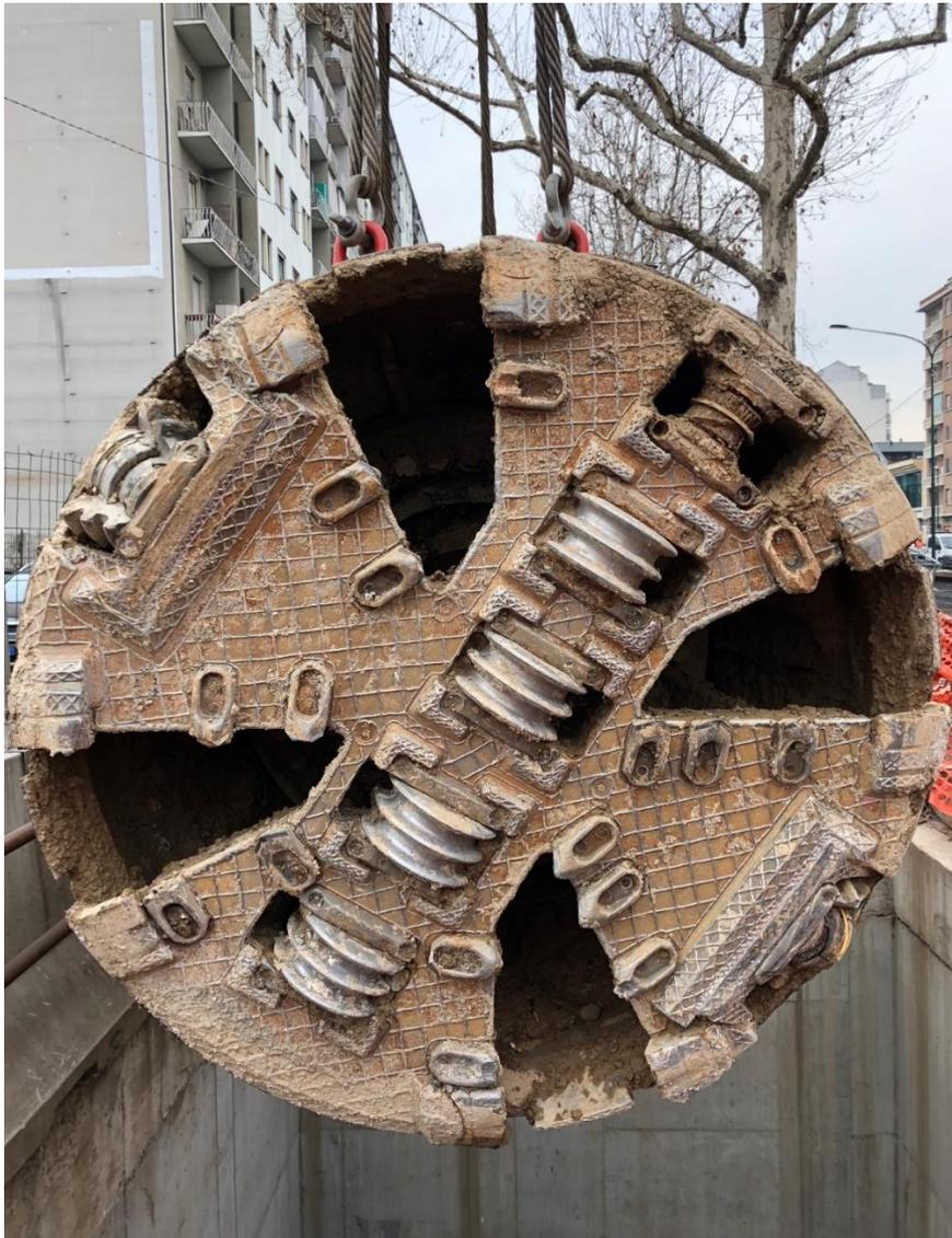
*Figura 99 – Fasi di rimozione della testa fresante della MTBM ultimata la prima tratta di dorsale n°15*
