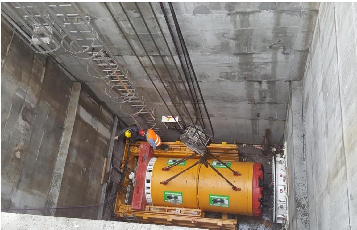
Figura 64 – Fase di installazione del microtunneller a fondo pozzo, collegamento dei cavi elettrici e condotta di mandata e ritorno del fango bentonitico.
