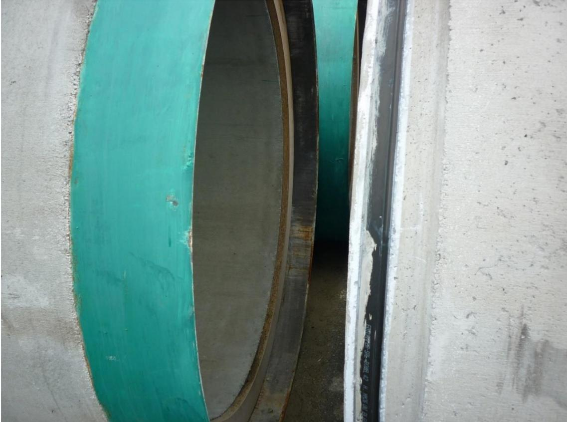
*Figura 85 – Vista sistema di giunzione maschio femmina di due tubi contigui*
