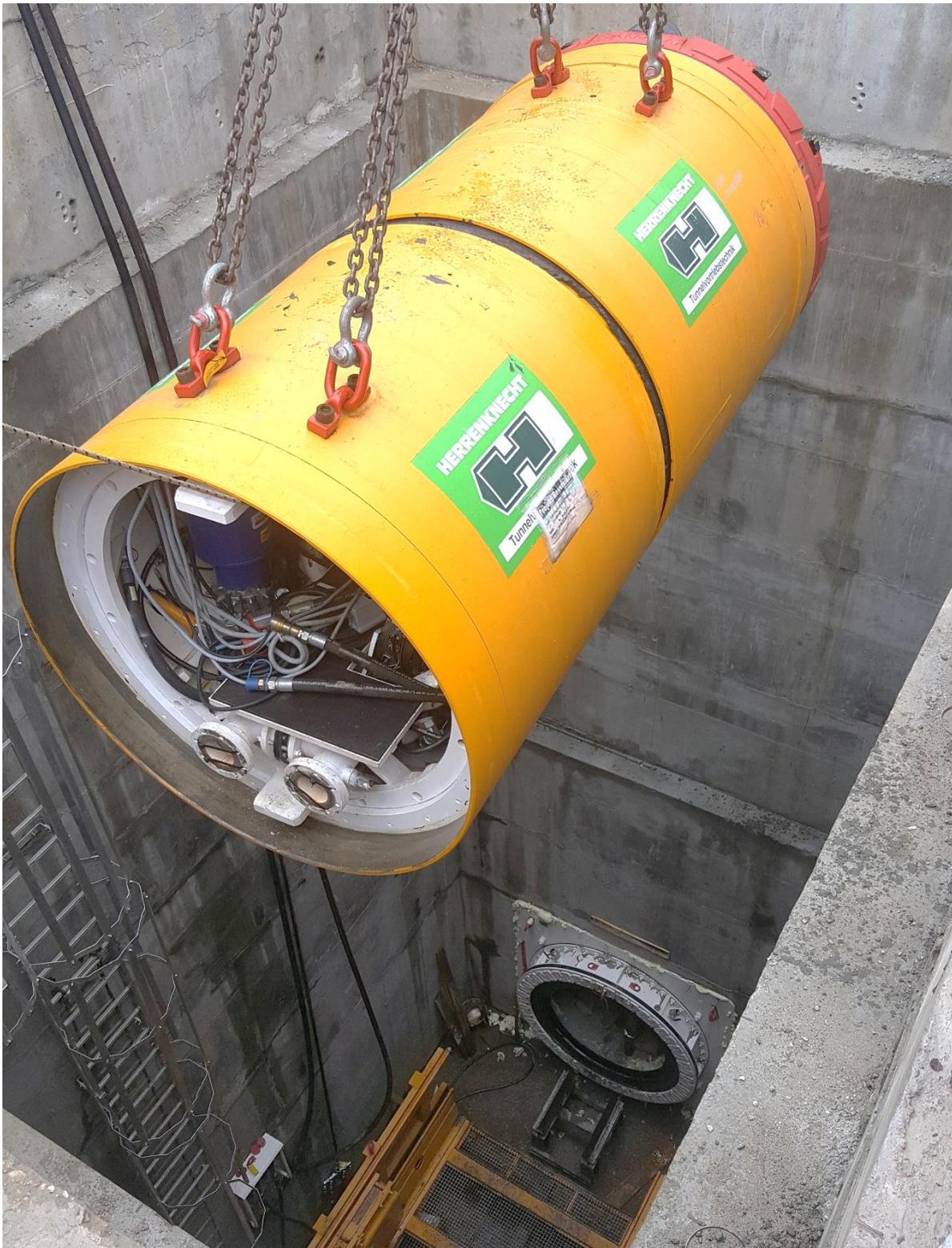
*Figura 62 – Fase di sollevamento e movimentazione del microtunneller con l'impiego di una gru mobile autocarrata e semovente. Particolare condotta di mandata e ritorno del fango bentonitico. A fondo pozzo, posto ad una quota di -13,60 metri dal p.c., si osserva la presenza dei carrelli di spinta con martinetti idraulici laterali, del sistema frenante e dell'anello di tenuta*
