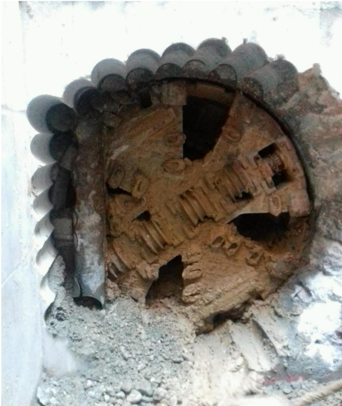
*Figura 98 – Vista dal pozzo di estrazione S1-16 della testa di scavo della MTBM e del micropalo da tagliare (ITINERA S.p.A.)*
