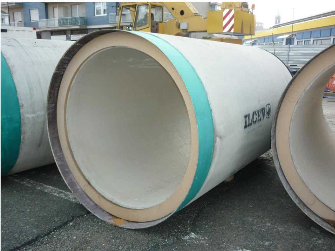
*Figura 80 – Tubazioni ILCEV S.R.L. impiegate per la realizzazione della tratta n°15 di fognatura nera, diametro interno 1500 mm, diametro esterno 1790 mm e lunghezza utile 3000 mm*
