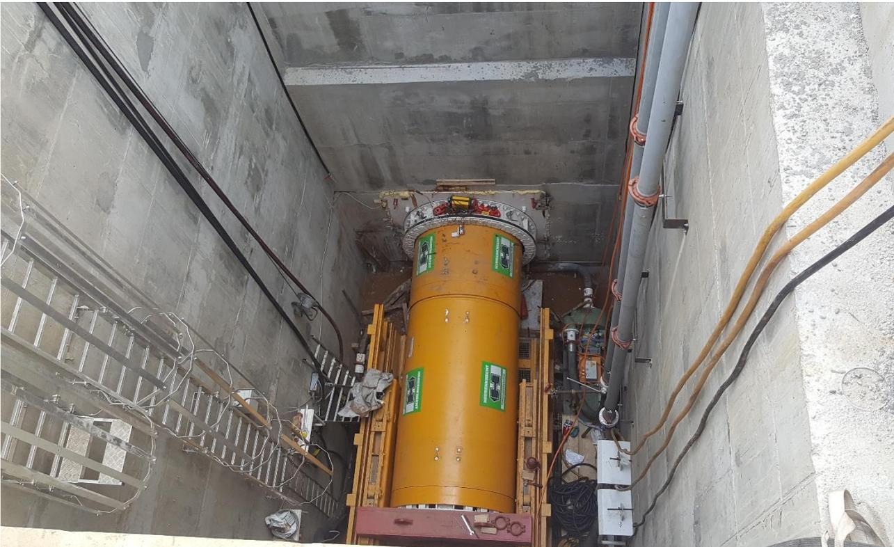
Figura 66 – Fase di installazione del back-up del microtunneller una volta completata la fase di installazione e spinta della sezione frontale della macchina, particolare condotta di mandata e ritorno del fango bentonitico e cavi elettrici
