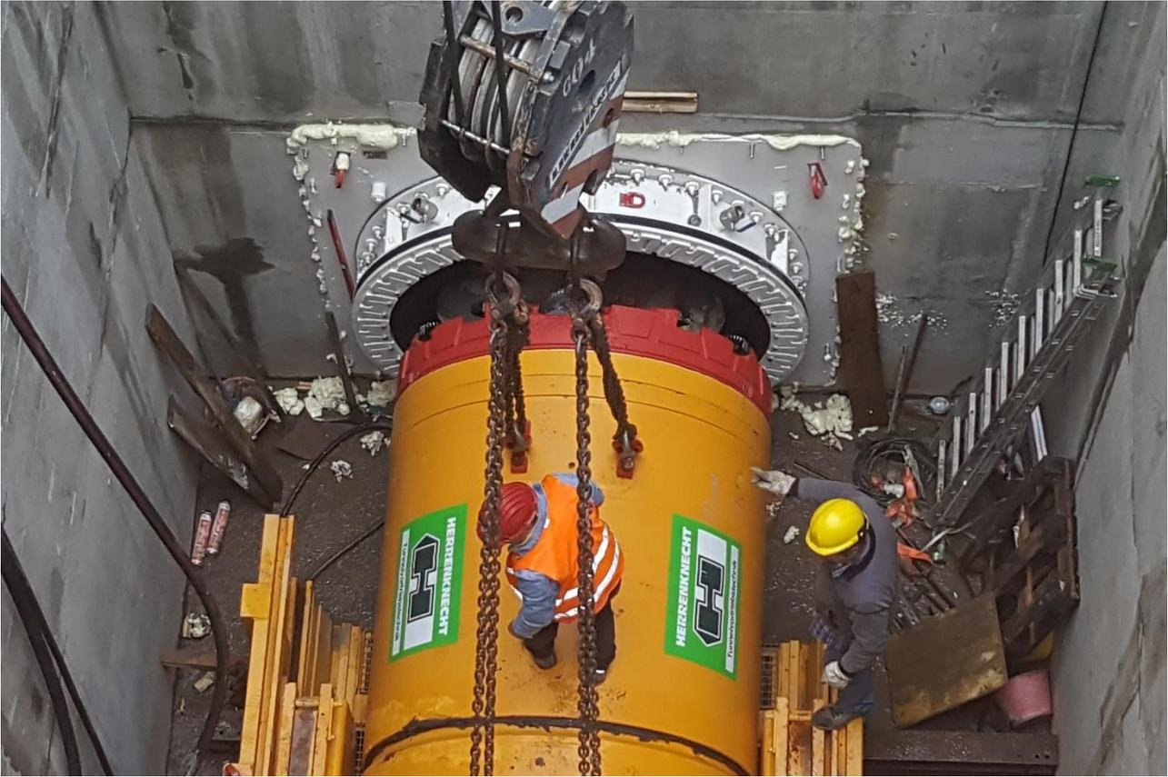
Figura 65 – Fase di installazione del microtunneller a fondo pozzo, anello di tenuta idraulica intestato sulla testa di perforazione
